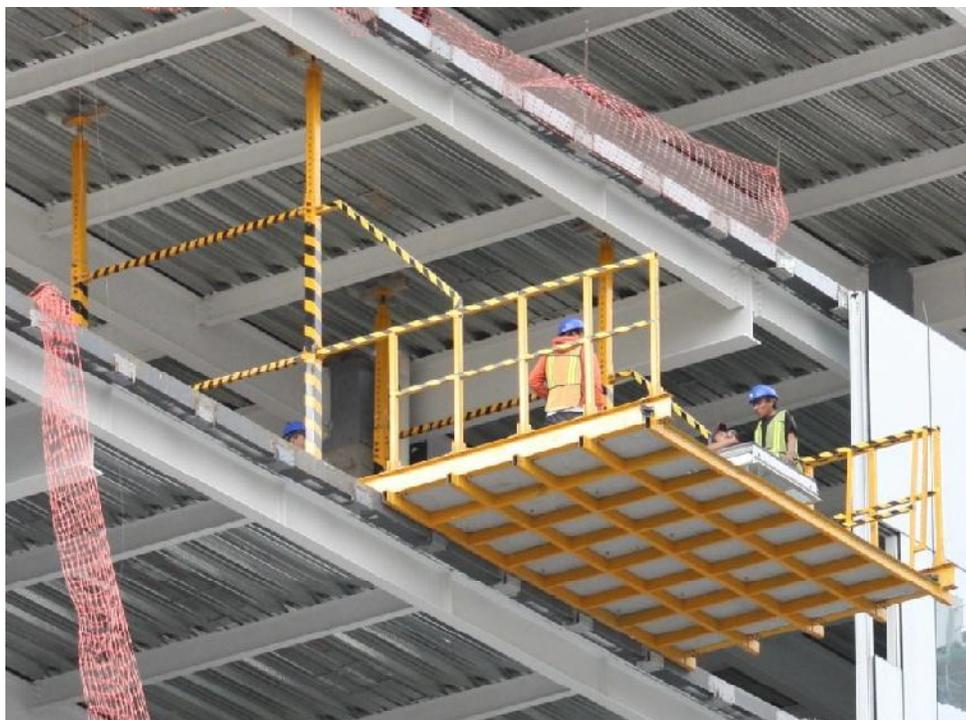
Fig. 23 Plataforma de descarga de materiales
