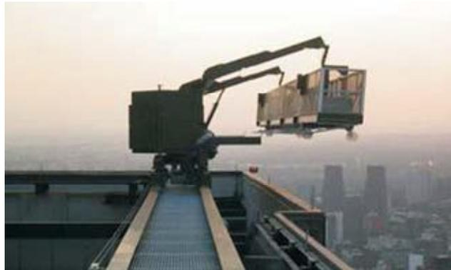
Fig. 1 Instalación de equipo permanente de acceso suspendido para mantenimiento de fachada. Torre Pemex
