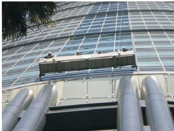
Fig. 2 Instalación de equipo temporal de acceso suspendido para mantenimiento de fachada. Torre Mayor
