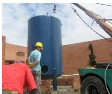
Imagen 7. Instalación de un recipiente sujeto a presión.
