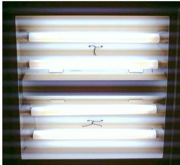
Figura 48. Lámpara fluorescente substituida de cuatro tubos fluorescentes de 21[W] cada uno.
