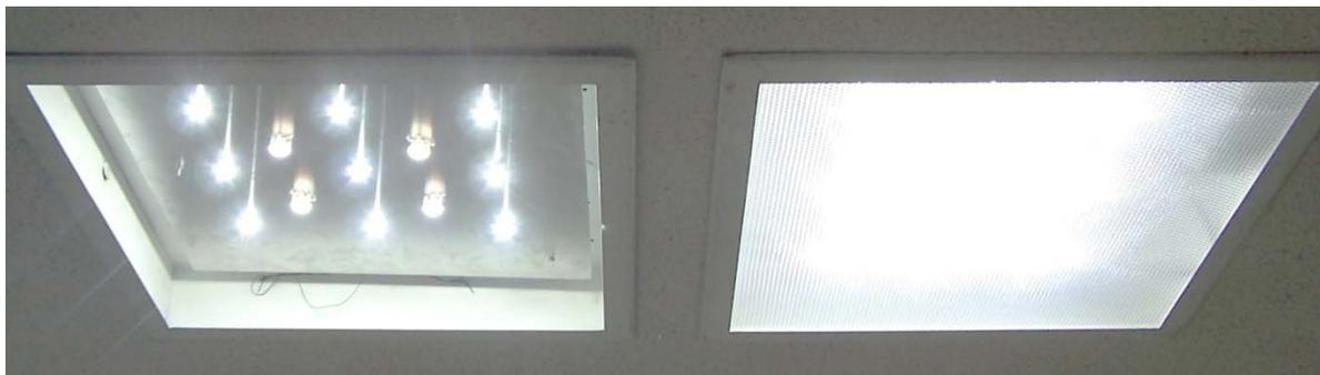
Figura 46. Arreglo de la izquierda sin difusor. Arreglo de la derecha con difusor.
