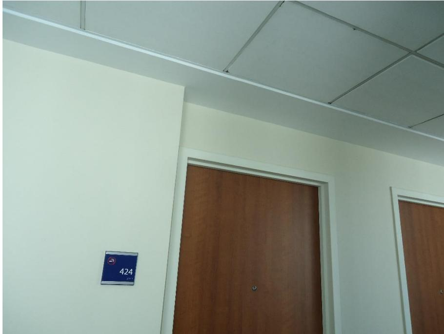
*Figura 39. Los muros y techos son aparentes de tablaroca así que técnicamente no presentarían mucha atenuación (pérdida de potencia en la señales).*
