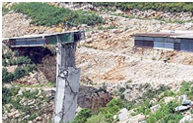
Figura 5.6: Colapso de la mitad del puente San Cristóbal (Notimex, 2004)
