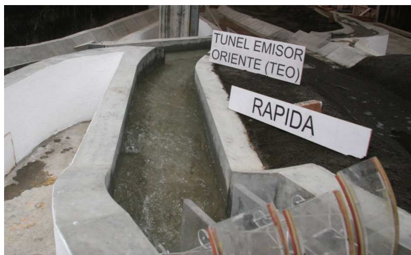
Vista del canal de conducción hacia la intersección del TEO con el TEC en dirección al distrito de riego (compuertas totalmente abiertas)
