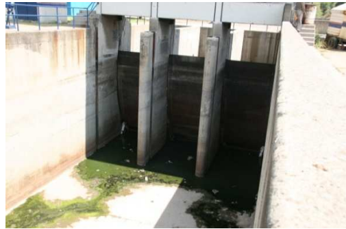
Fig. 2.1.7 Estructura de control
