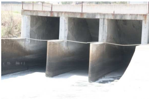
Fig. 2.1.8 Túnel alcantarilla bajo el río El Salto
