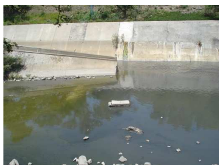
Fig. 3.2 Zona de confluencia
