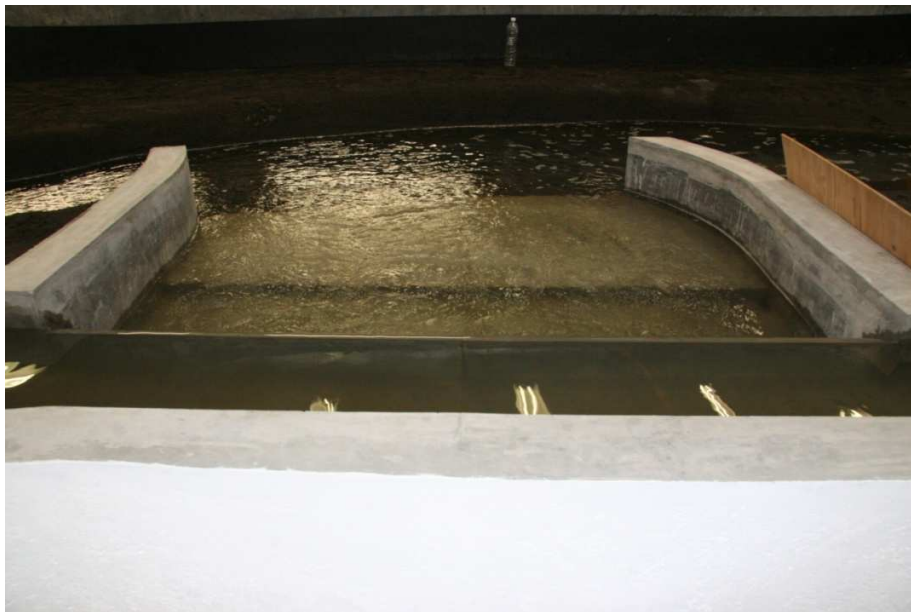
Fig. 5.1.2 Detalle del vertedor de excedencias del TEO
