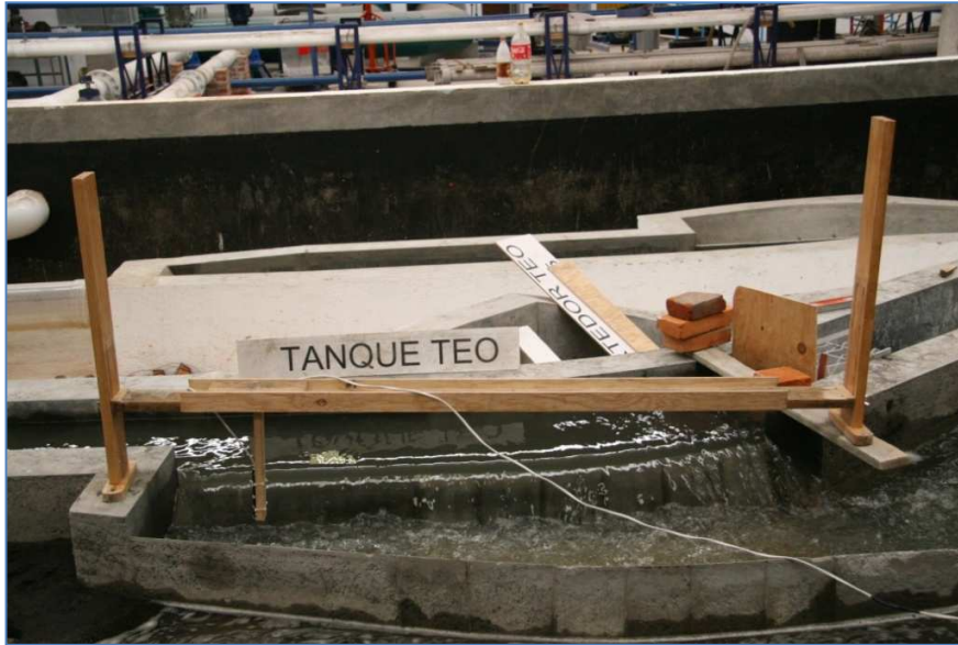
Medición al inicio del tanque del vertedor sobre la plantilla
