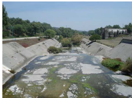
Fig. 2.1.9 Rectificación del río El Salto
