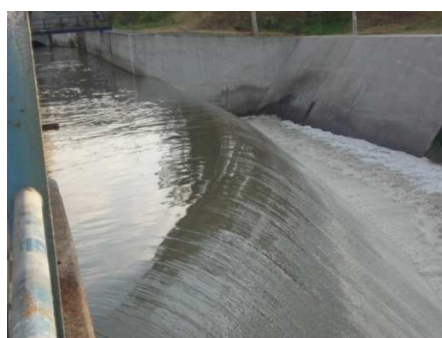
Fig. 2.1.5 Vertedor de excedencias
