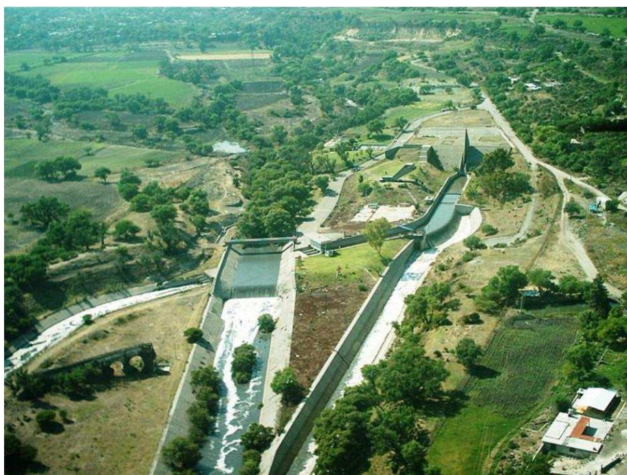
Fig. 2.1.1 Obra derivadora del Túnel Emisor Central
