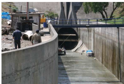
Fig. 2.1.2 Portal de salida
