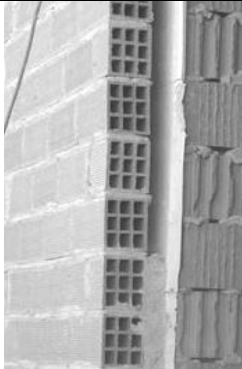
Figura 38. Muros de doble hoja, aislamiento con poliestireno y cámara de aire.
