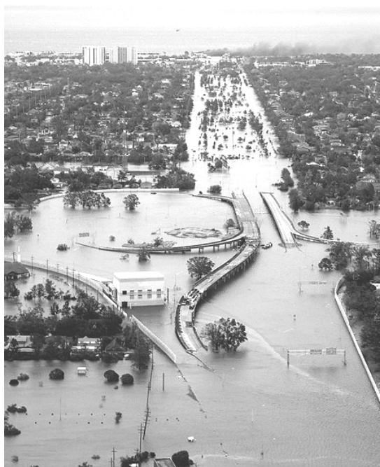
Figura 1. Estragos del Huracán Katrina en Louisiana.
