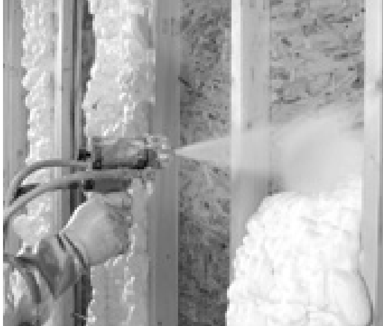
Figura 34. Aplicación de poliuretano esreado en muros.
