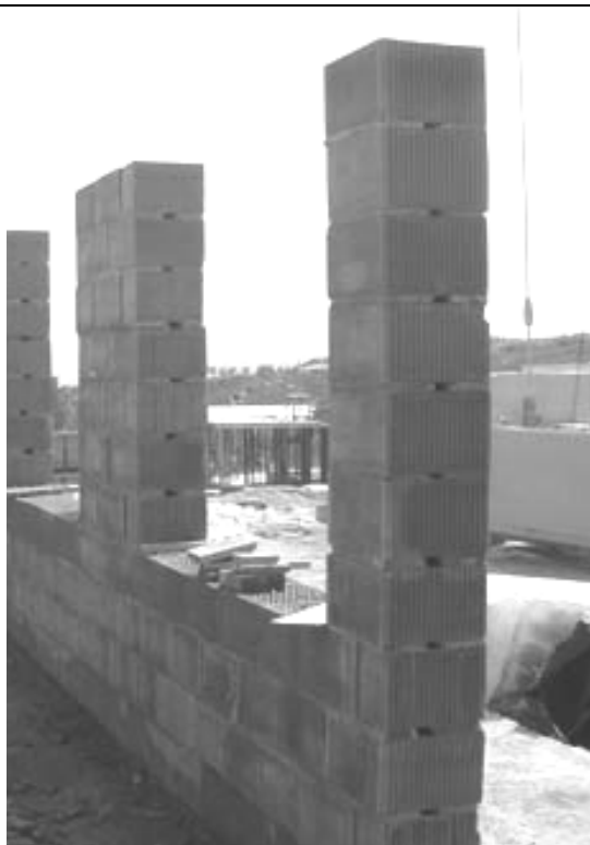
Figura 37. Mampostería con continuidad entre cámaras de aire
