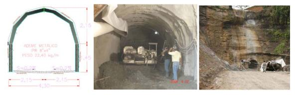
Fig. 27. Esquema y vista de la galería de drenaje ubicada aguas arriba.
