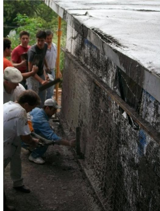
Al termino de los trabajos de Aplanado es imprescindible curar la superficie del muro de tal manera que no se pierda la humedad, y con ello prever la aparición de grietas.
