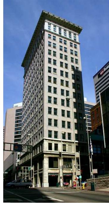
Foto 5.- Edificio Ingalls, Cincinnati, EUA, 1903, 1er. Edificio de Concreto.
