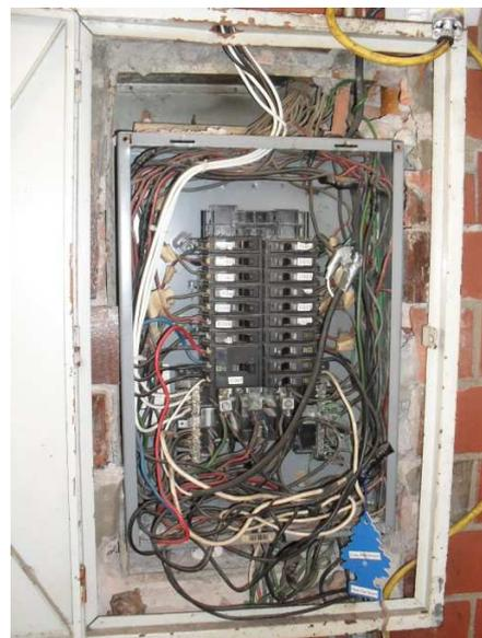
Figura 4.5 Tablero 1D con saturación de conductores
