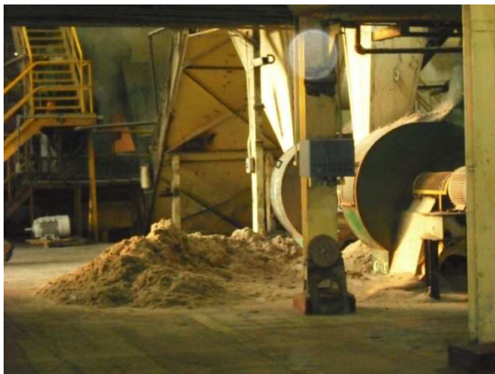
Fotografía A5.23 Bagacillo destinado a ventiladores para cachaza
