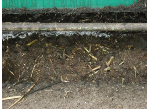
Fotografía A5.2 Detalle - lodo debajo del conductor principal de caña
