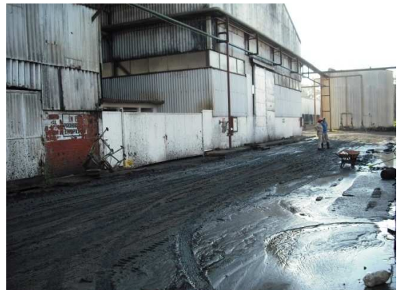
Fotografía A5.24 Derrame de decantador de lodos de ceniza
