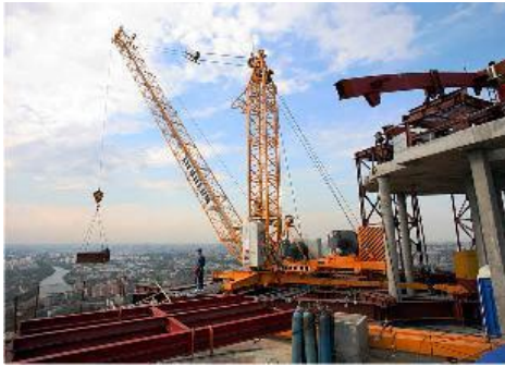
Ilustración 3.37 Grúa Derrick para el desmontaje de grúas
