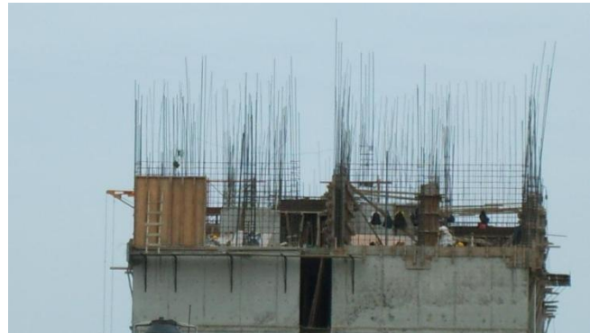
Ilustración 2.36 Armado de muro
