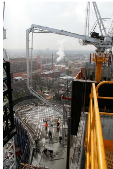
Ilustración 2.18 y 2.19 Cimbra auto-trepante con pluma colocadora de concreto
