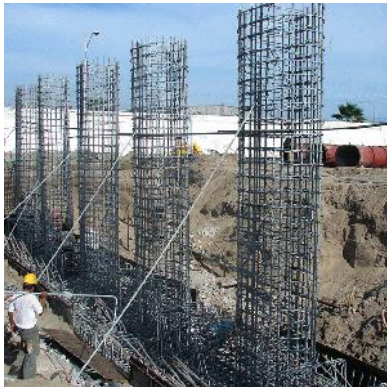
Ilustración 2.35 Armado de columna, con tensores
