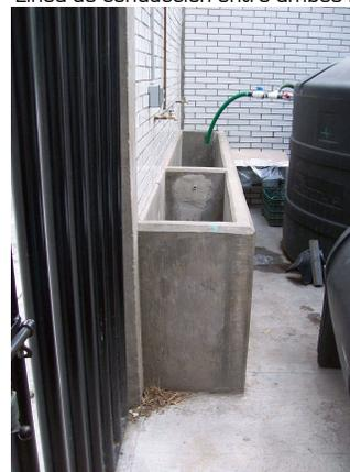
Estanques de sedimentación de efluentes
