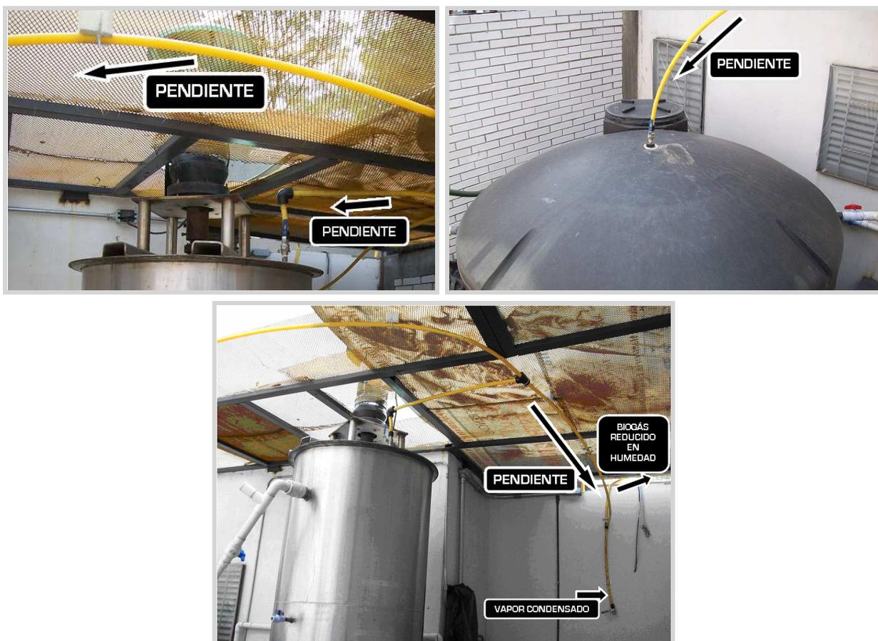
Figura V.7 - Dirección de las pendientes en la colocación de la tubería de conducción del biogás
