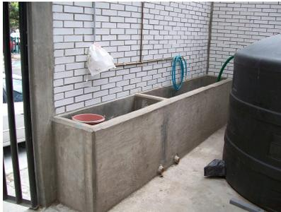
Estanques de sedimentación y reactor R-II
