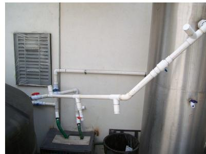
Línea de conducción entre ambos reactores
