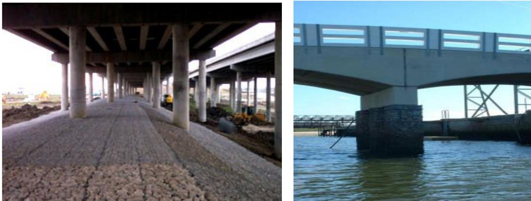
Figura 5.14. Instalación de gaviones como protección de pilas.
