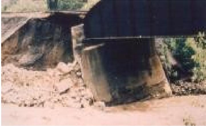
Figura 5.2. Socavación local en pilas de puentes. Gary L. Lewis (2004).
