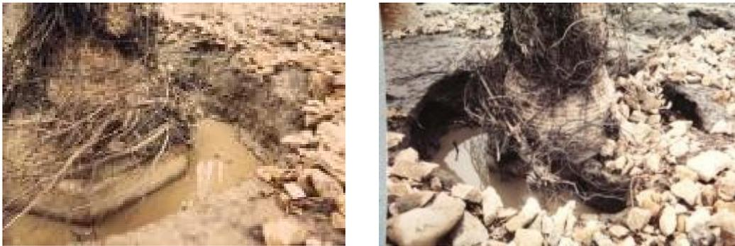
Figura 5.3. Socavación en pilas de puente. Gary L. Lewis (2004).
