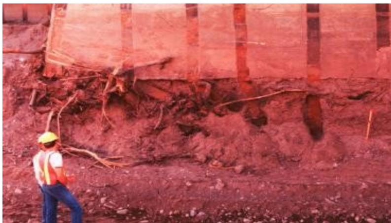
Figura 5.4. Socavación en pilas de puentes. Gary L. Lewis (2004).
