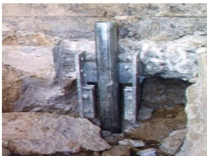
Figura 5.19. Refuerzo de una pila.
