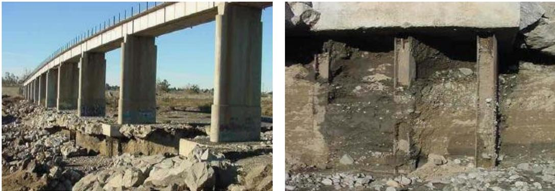
Figura 5.11. Socavación por degradación del fondo. Gary L. Lewis (2004).
