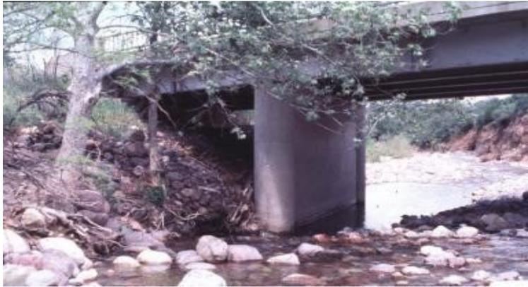
Figura 5.5. Socavación en estribos. Gary L. Lewis (2004).
