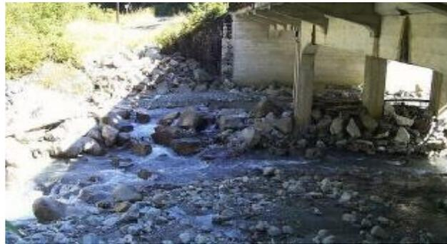
Figura 5.13. Rip rap para protección de pilas. Washington State Department of Transportation (2006).
