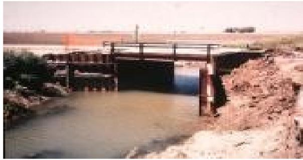
Figura 5.8. Socavación por expansión del flujo Gary L. Lewis (2004).
