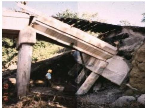
Figura 5.6. Socavación por movimiento lateral del cauce. Gary L. Lewis (2004).
