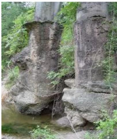
Figura 5.7. Socavación por degradación. Gary L. Lewis (2004).
