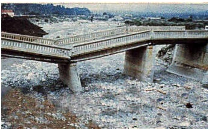
Figura 5.1. Ejemplo de falla en un puente por socavación en pilas.
