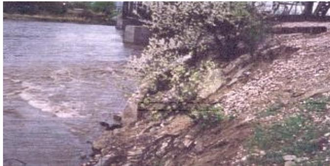
Figura 5.9. Socavación en pilas por ángulo de incidencia adverso. Gary L. Lewis (2004).
