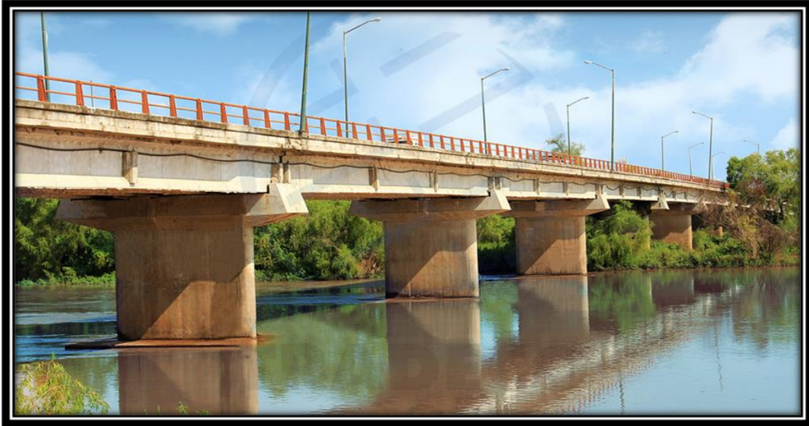
Figura I.7 Puente Santiago-La Presa, Nayarit México.
