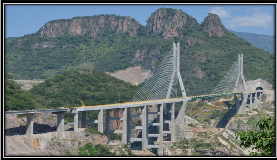
Figura I.3 Puente Baluarte, Autopista Durango México.
