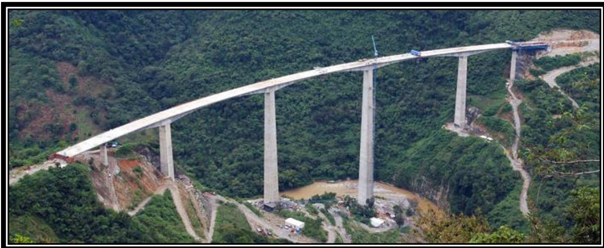
Figura I.4 Puente San Marcos, Puebla México.
