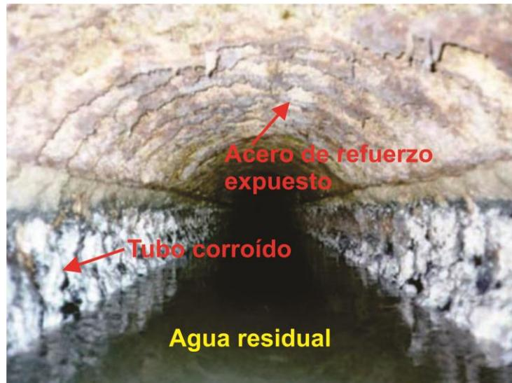
**Figura 2.2 Tubería de concreto corroída con el acero de refuerzo expuesto**
