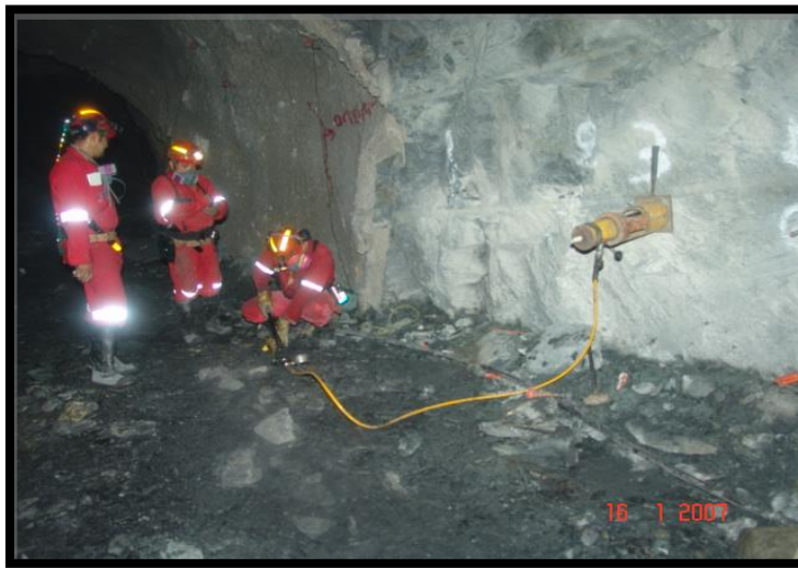
Figura No. IV.12. Pruebas de extracción de anclas
