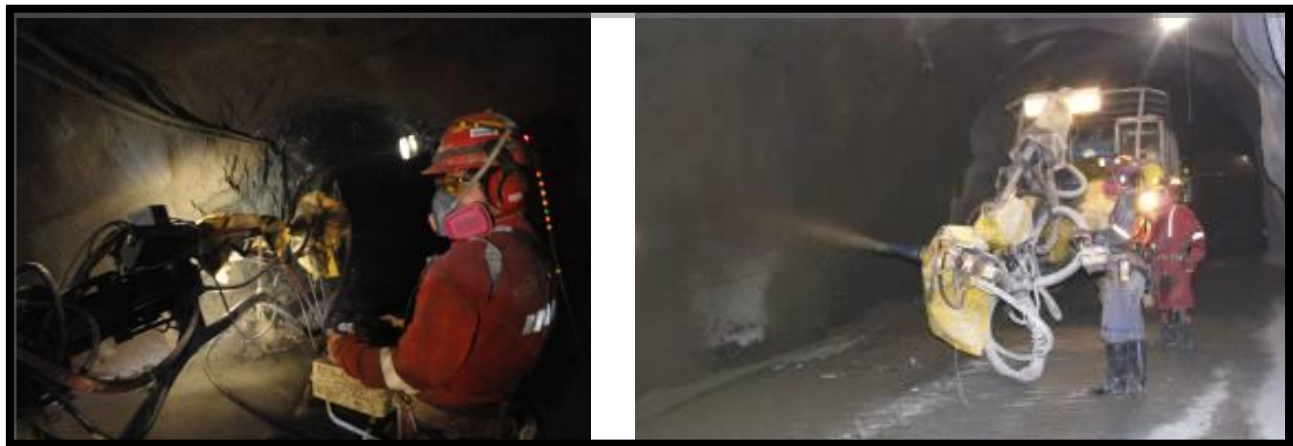
Figura No. IV.15. Aplicación de concreto lanzado con Robot Alpha 20
