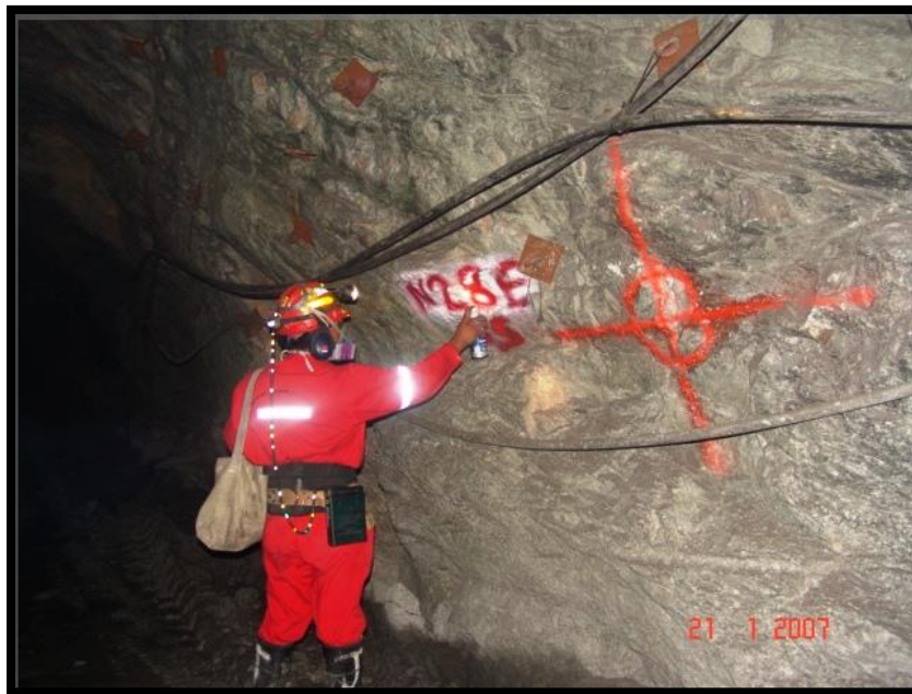
Figura No. IV.4. Marcaje de centro y nombre de pilar
