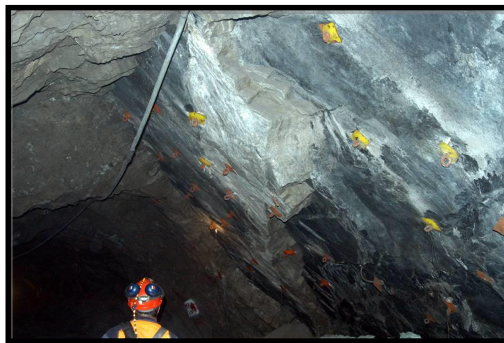
Figura No. IV.7. Ancla de varilla corrugada colocada en rebaje
