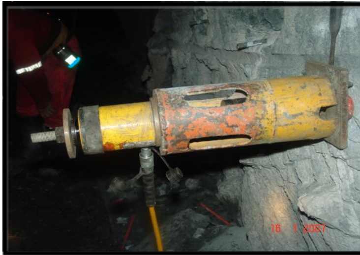
Figura No. IV.13. Celda de carga, para pruebas de extracción de anclas
