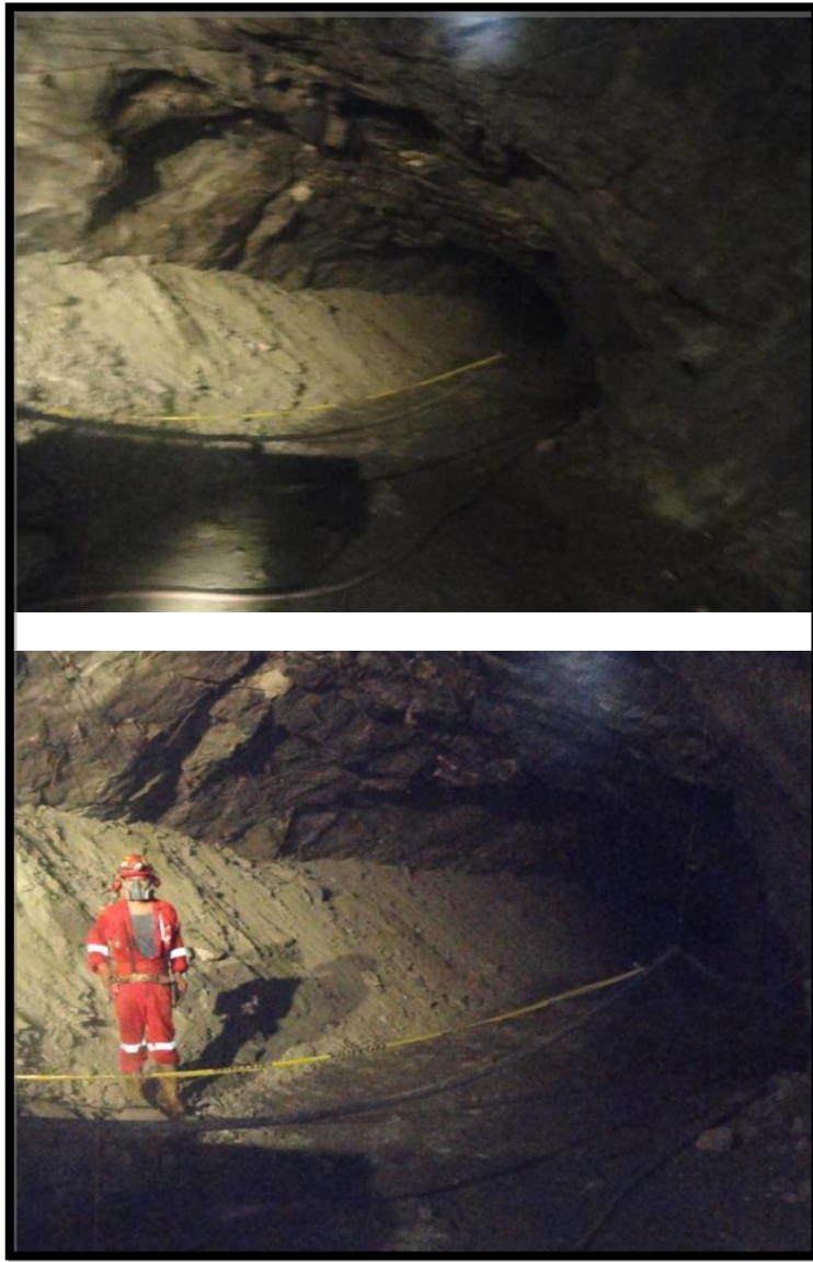
Figura No. V.3. Cargado de tepetate al alto del rebaje 740 centro
