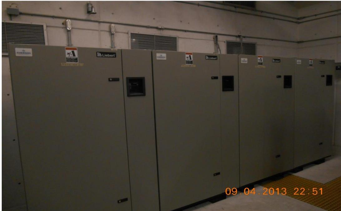
Fotografía 8 Bancos de baterías de los UPS Liebert serie 610. Dos bancos en paralelo por UPS. Cada Banco tiene 40 Baterías.
