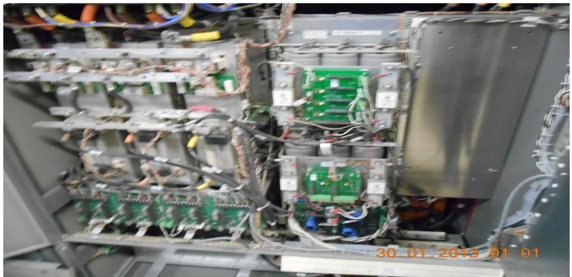
Fotografía 11 Electrónica de potencia, tarjetas de control y lógica de UPS Liebert serie 610.
