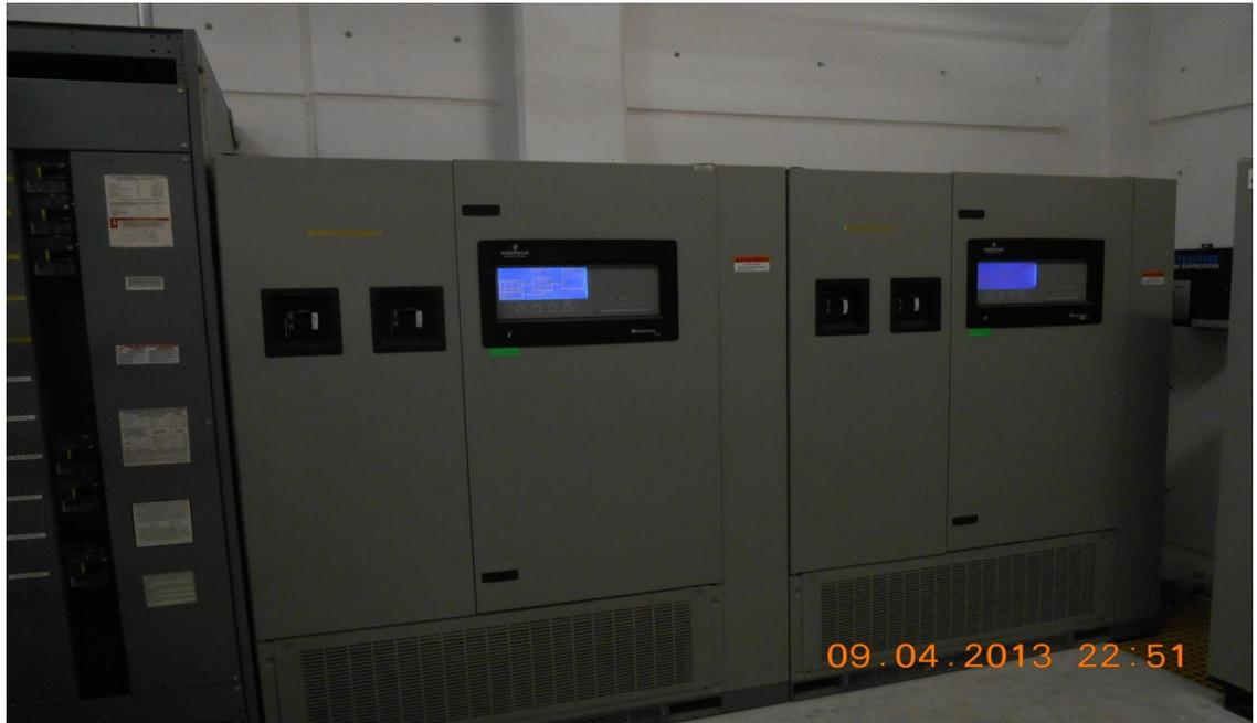
*Fotografía 6 UPS Liebert serie 610, con capacidad 225KVA, conectados en modo paralelo redundante.*
