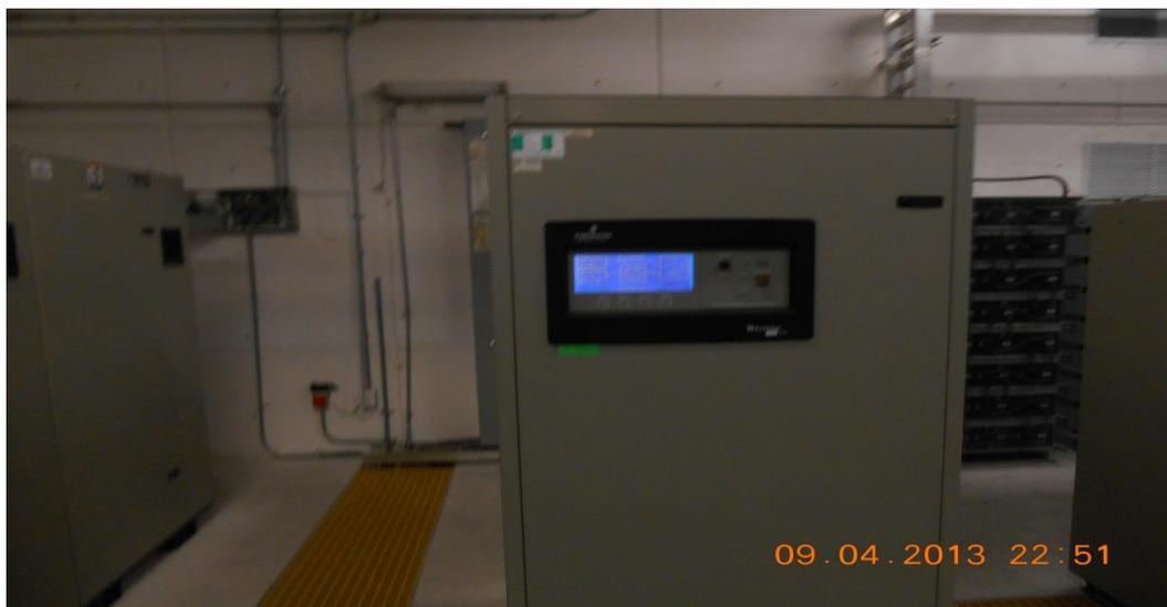
*Fotografía 7 Control SCC, de los UPS Liebert Serie 610 conectados en paralelo redundante.*
