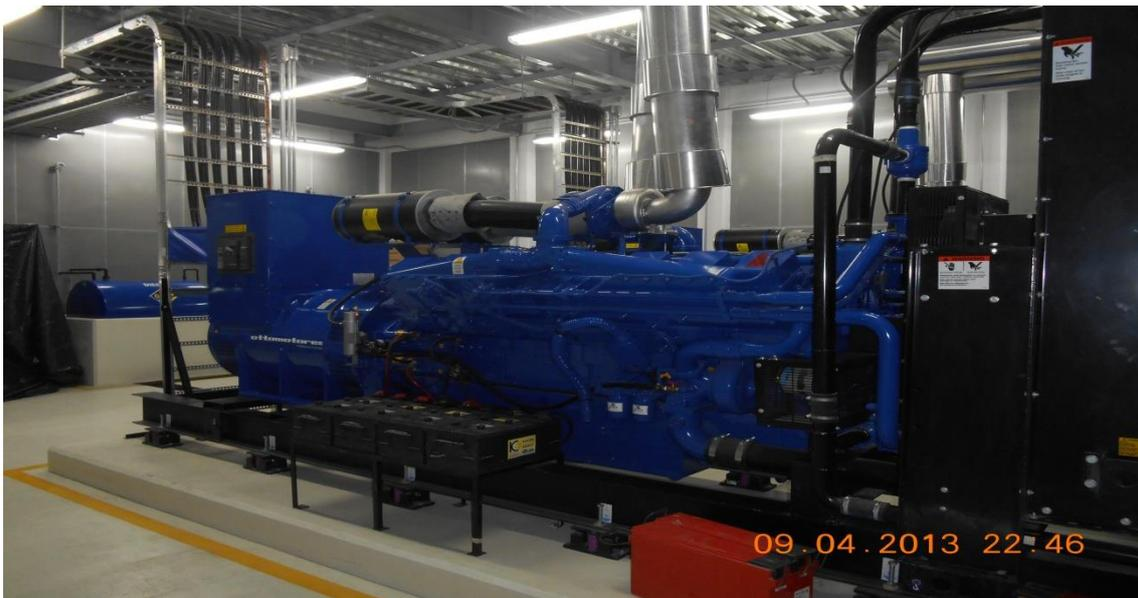
*Fotografía 5 Planta de emergencia marca OTTOMOTORES de 1500 KW*
