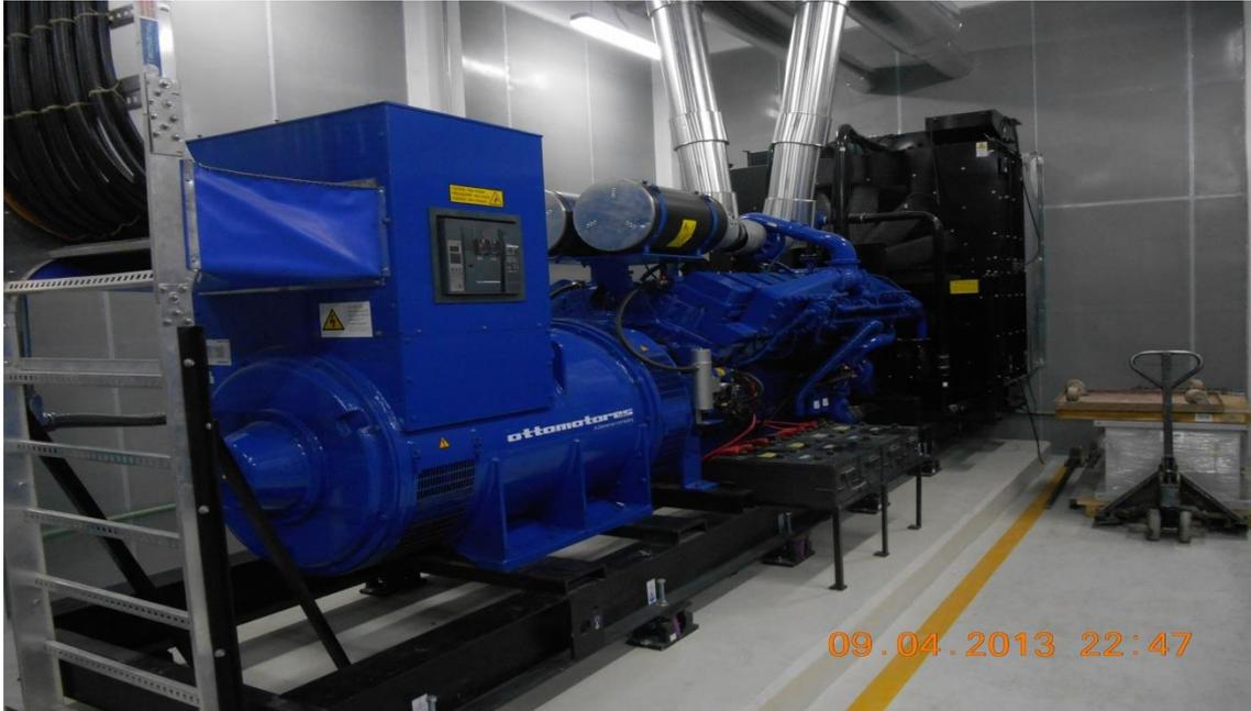
*Fotografía 4 Planta de Emergencia marca OTTOMOTORES de 1500 KW, motor CUMMINS, generador síncrono STANFORD.*
