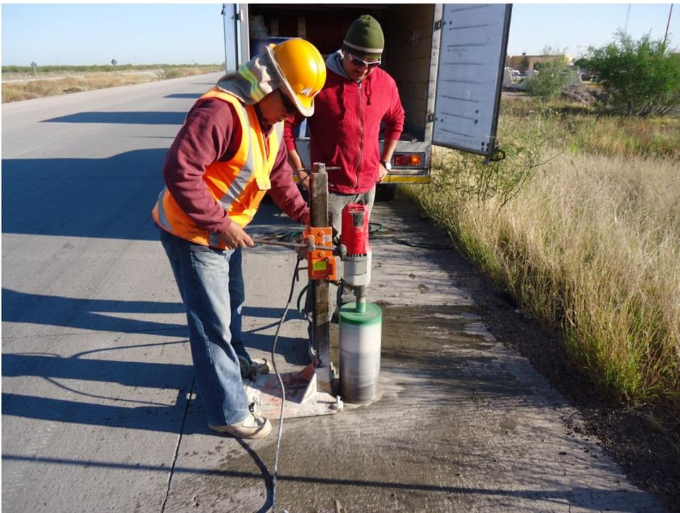
**Figura 9. Equipo de alto rendimiento en sondeos**
