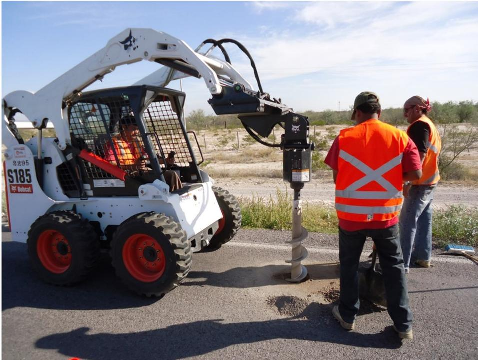
**Figura 8. Equipo de alto rendimiento en sondeos**
