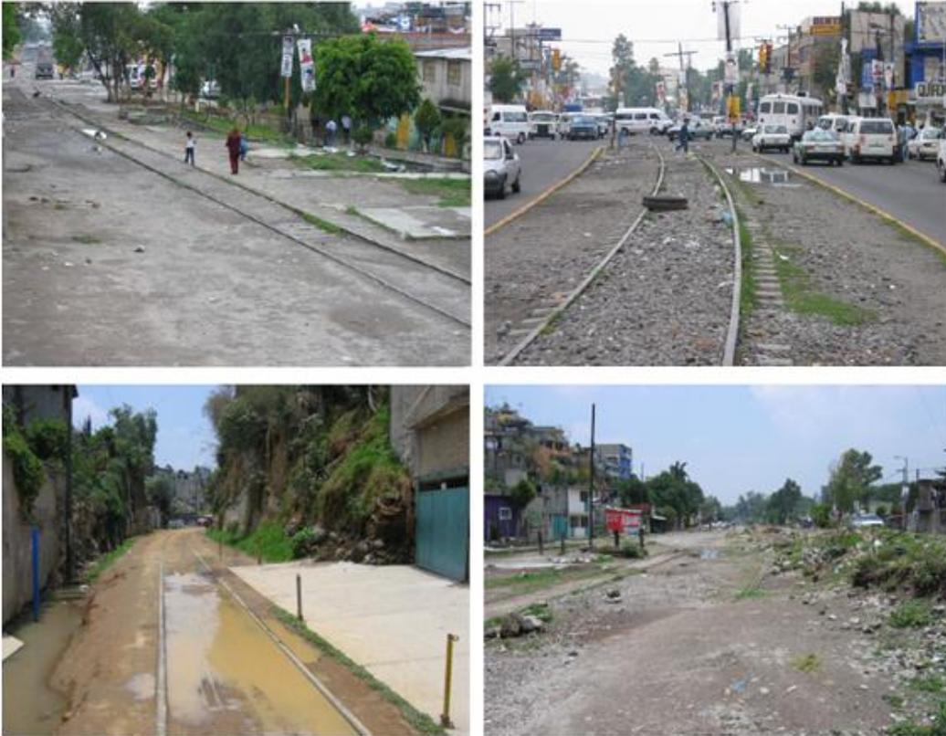
Figura # 2.4. Invasión al derecho de vía de la Línea N en diferentes zonas de Naucalpan.
