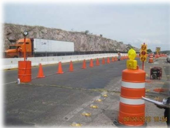
Figura 11. Dispositivos de protección e iluminación
