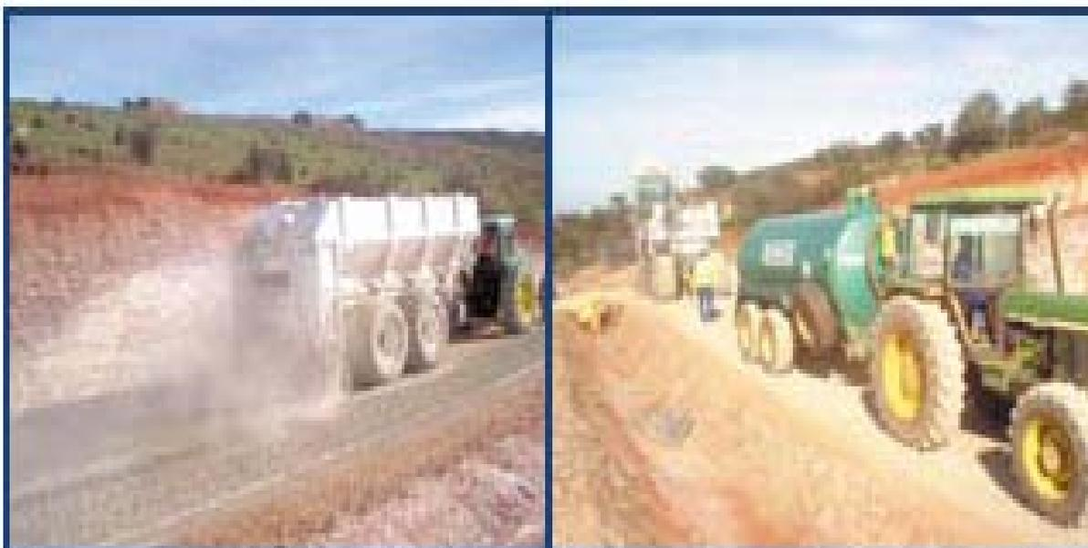
Fig. IV.3.2.- Extendido de cemento (izq.) y tren de reciclado in situ enganchado a tractor cuba (der.)
