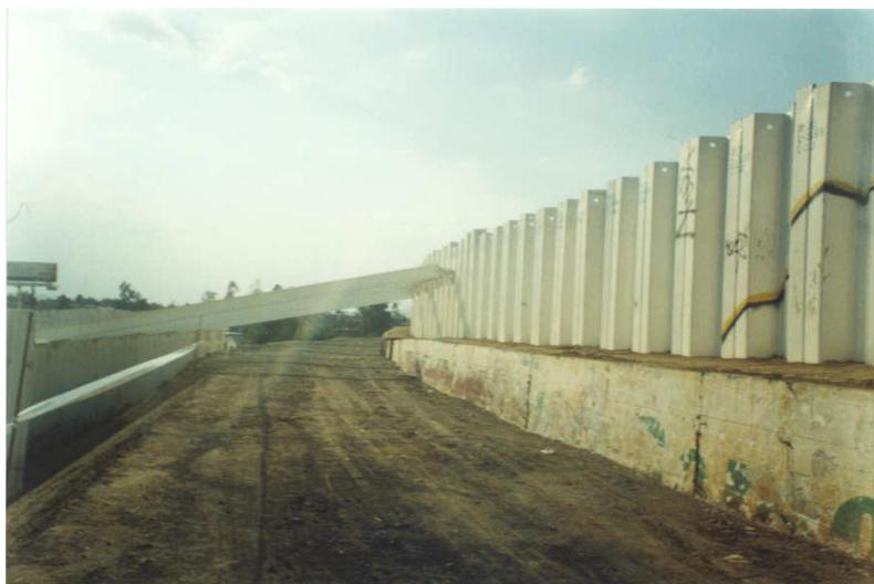
**Ilustración 5: Tablestacado en el lado interior del bordo**
