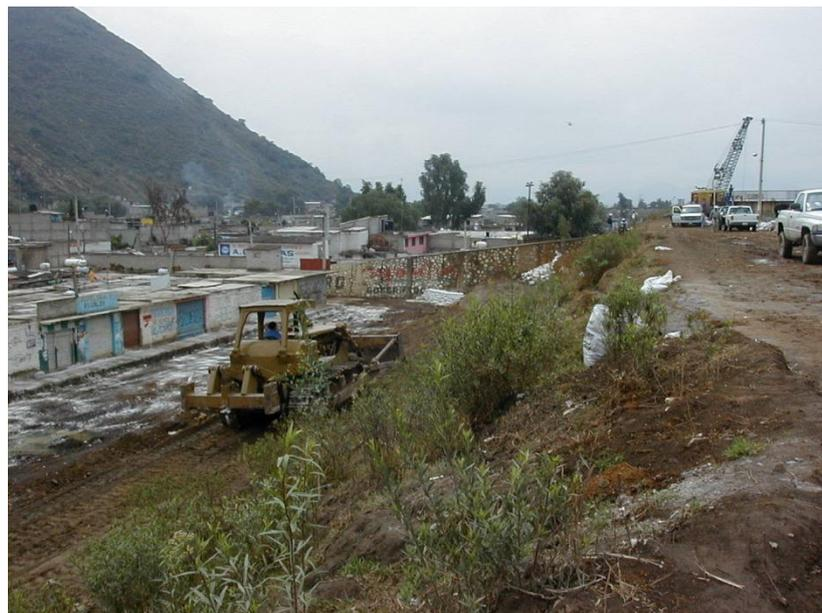
**Ilustración 7: Sobreelevación y reparación de los bordos**
