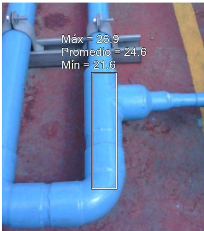
**Figura 37.** Salida de agua de la última fila de colectores solares.
