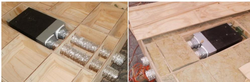
*Fig. V-6. Proceso de ensamblaje de los ventiladores.*
