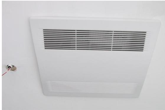
*Fig. V-7. Instalación de las rejillas interiores en CASA-UNAM.*
