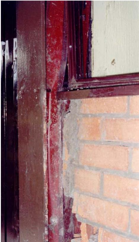
*Figura 1.1.2 Deficiente separación de los muros de relleno en una escuela secundaria en el poblado el Chante, municipio de Autlán de Navarro. Jalisco*
