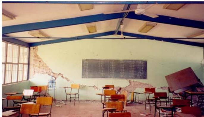
*Figura 1.1.1. Vista interior del daño observado en los muros divisorios de una escuela secundaria de Ixtlahuacán, Colima*
