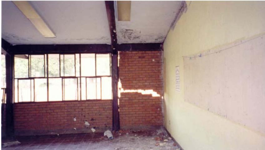
*Figura 1.1.4 Daño en muros de relleno en una escuela secundaria en el poblado el Chante, municipio de Aulán de Navarro*
