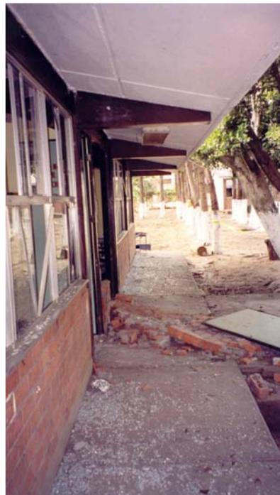
*Figura 1.1.3 Rotura de vidrios y daño en muros de relleno en una escuela secundaria en el poblado el Chante, municipio de Autlán de Navarro*
