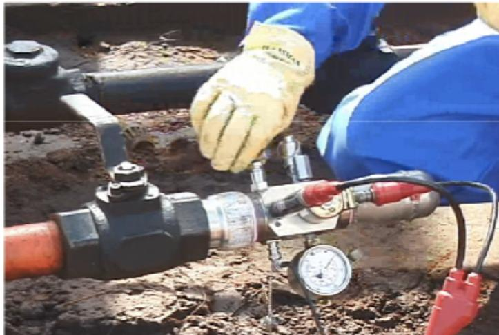
**Fig. 4.16** Válvula de purga.
