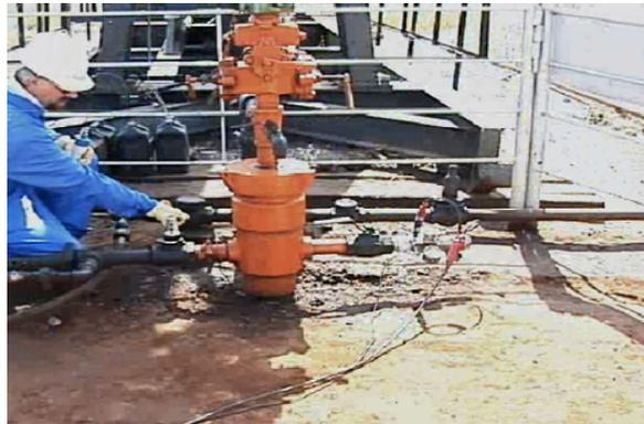
c) Cerrado de la válvula de la línea de descarga.
