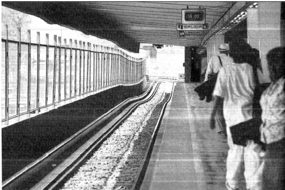
Ilustración 5.4 Vista interior de las vías.
