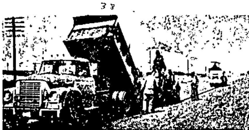
Fotografía 2, Trabajando en un carril ya escarificado y regado con agente rejuvenecedor, los pavimentadores del Distrito tienen espesores de 1.7 a 2.0 cms.
