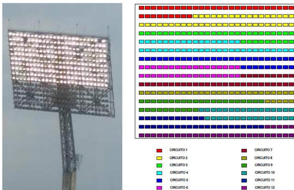
Figura 2. 6. Torre de iluminación (al 62.5%) y circuitos de encendido.<sup>14</sup>
