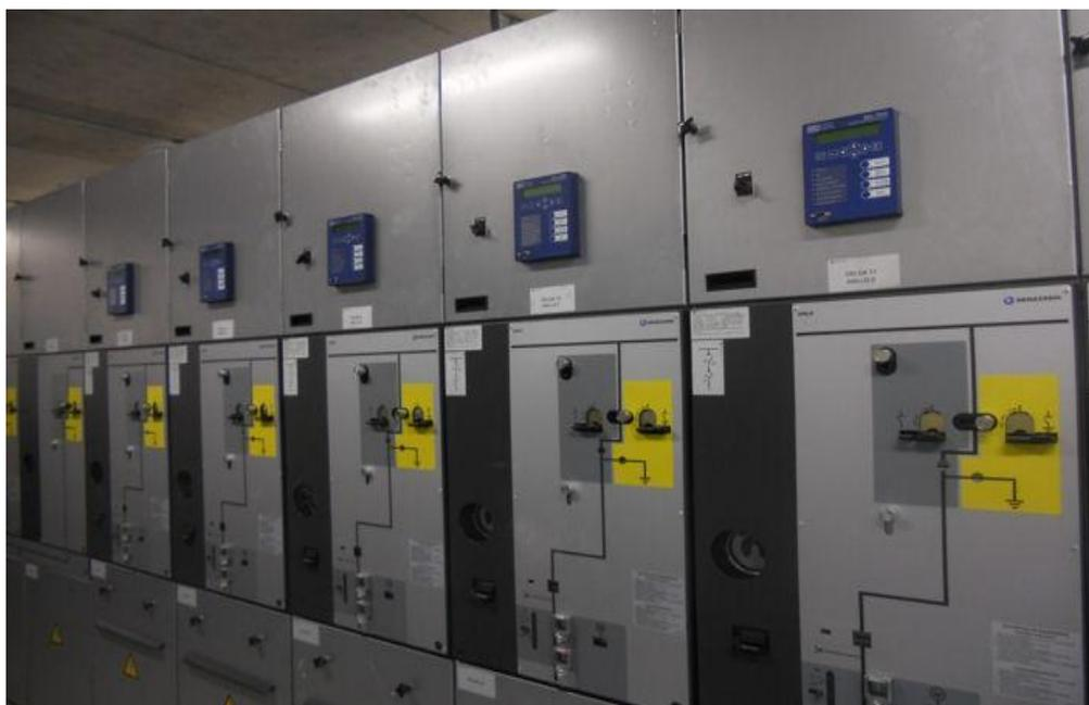
Fotografías 3. 2. Celdas modulares *Ormazabal* tipo *GIS*, modelo *CPG.o*.
