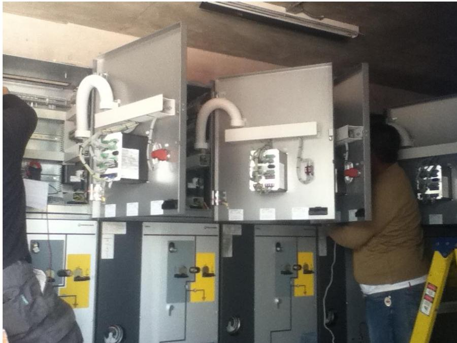
Fotografías 3. 3. Instalación de tableros generales *Ormazabal* tipo *GIS*, modelo *CPG.o*.
