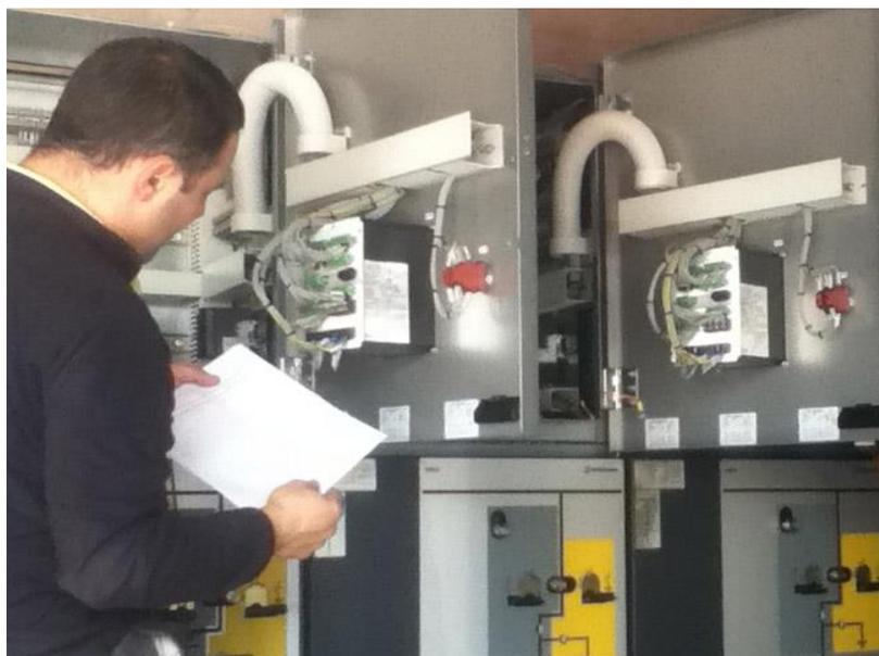
Fotografía 3. 4. Instalación del sistema de protección de alimentador *SEL-751A*.
