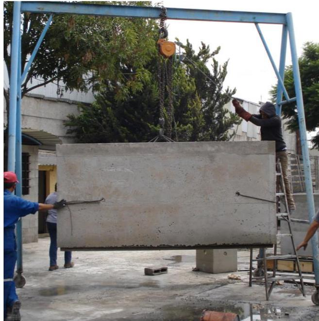
Figura 8, prefabricado Pieza2 anillo de caja de infiltración prefabricada, traspaleo para zona de embarque Fuente: propia, Referencia: plano 2-A
