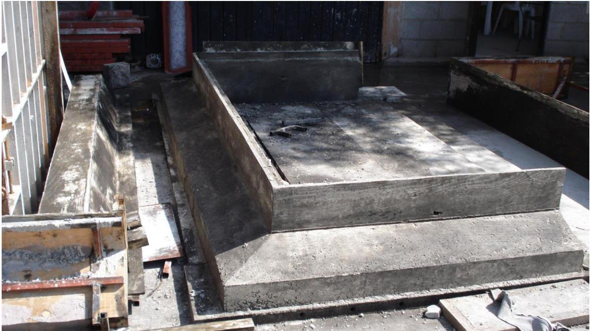
Figura 27, Pieza1 zapata de cimentación de caja de infiltración prefabricada
