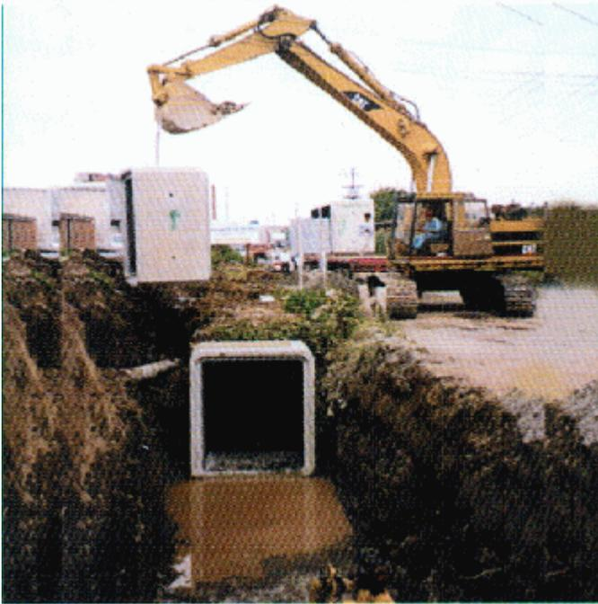
*Figura 30, Pieza2 maniobra para bajar prefabricado hacia ensamble de caja de infiltración prefabricada
