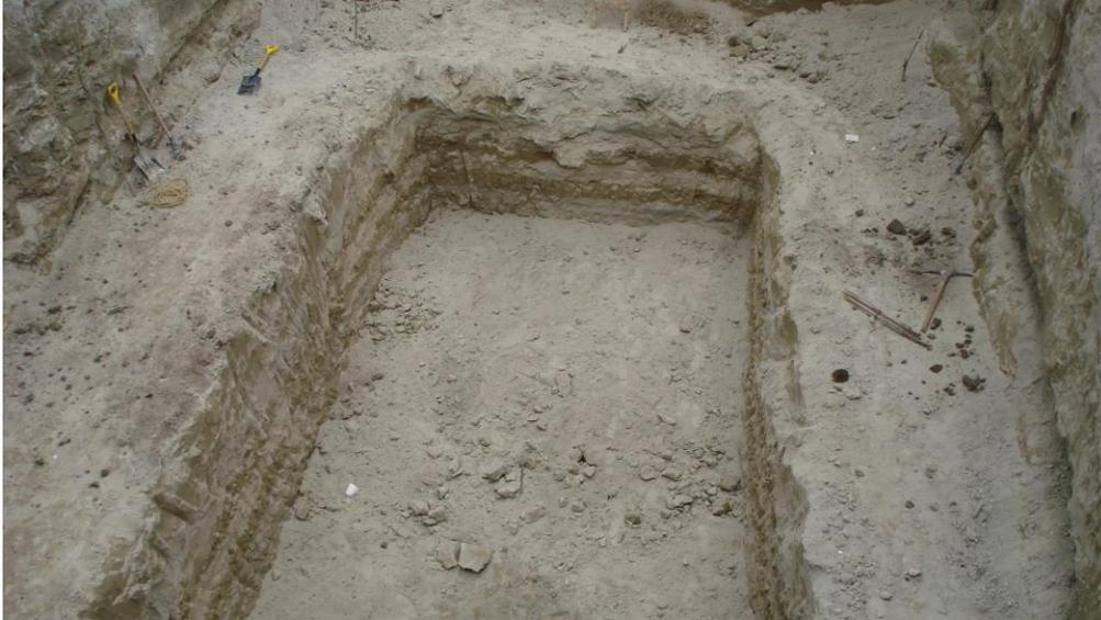
*Figura 19, excavación para de caja de infiltración prefabricada
