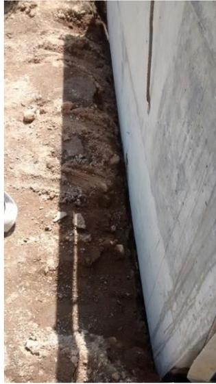
*Figura 32, anillo de caja ya montado y enterrados de la caja de infiltración prefabricada
