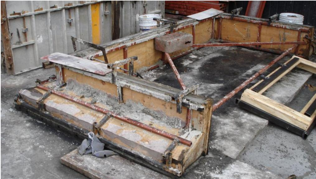
Figura 9, Elemento de Caja de infiltración, prefabricado Pieza1 zapata de caja de infiltración prefabricada
