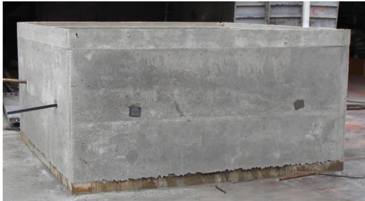
Figura 2, Anillo para caja de infiltración prefabricado Fuente: propia Referencia: plano 2-A
