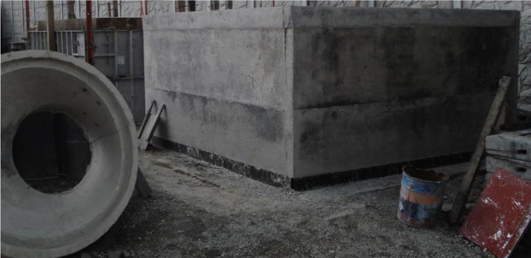
*Figura 36, Elemento de Caja de infiltración, (Pieza2 anillo de caja de infiltración prefabricada)
