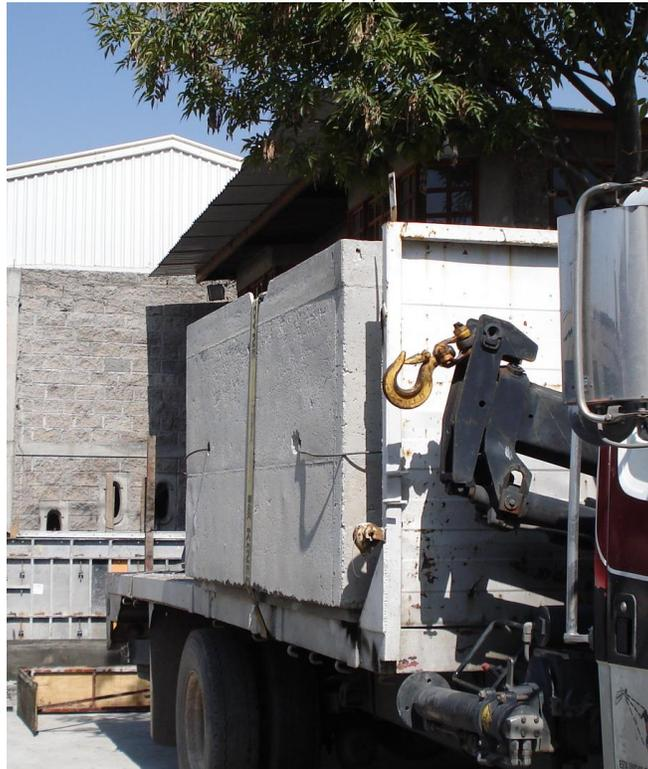
*Figura 22, transporte de flete con piezas prefabricadas
