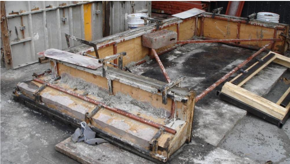
Figura 26, Vaciado de concreto Pieza1 zapata de cimentación de caja de infiltración prefabricada, fabricación
