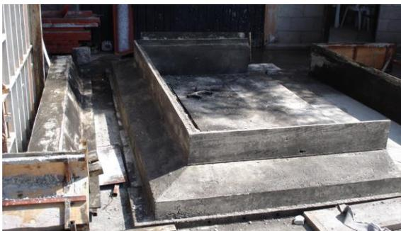
Figura 4, Elemento de Caja de infiltración, (zapata de cimentación para base de caja de infiltración prefabricado)
