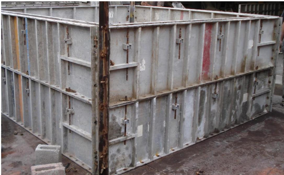
Figura 13, cimbra para pieza 2, anillo de caja de infiltración prefabricada
