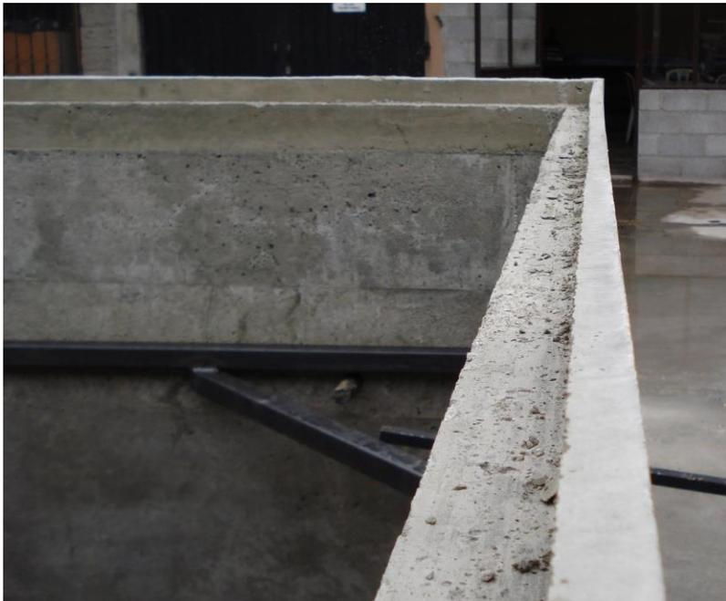
*Figura 31, Machimbre y/o junta, de anillo de caja de infiltración prefabricada
