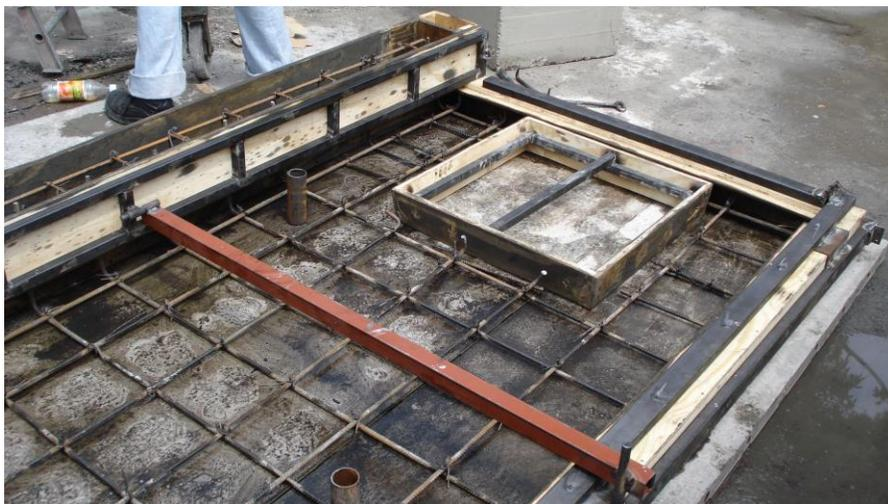
Figura 17, Armado de acero y cimbra para un vaciado monolítico de Pieza3 Losa tapa
