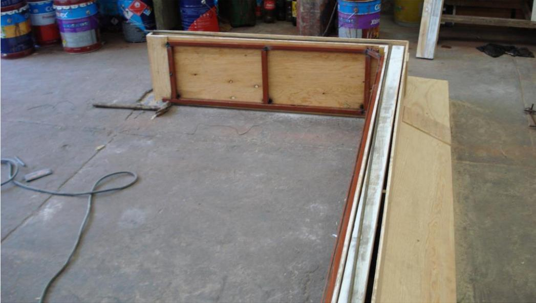
Figura 25, cimbra para un vaciado monolítico de Pieza1 zapata de cimentación, fabricación.
