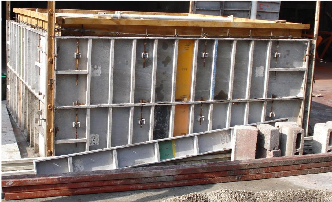
Figura 12, cimbra para pieza 2, anillo de caja de infiltración prefabricada
