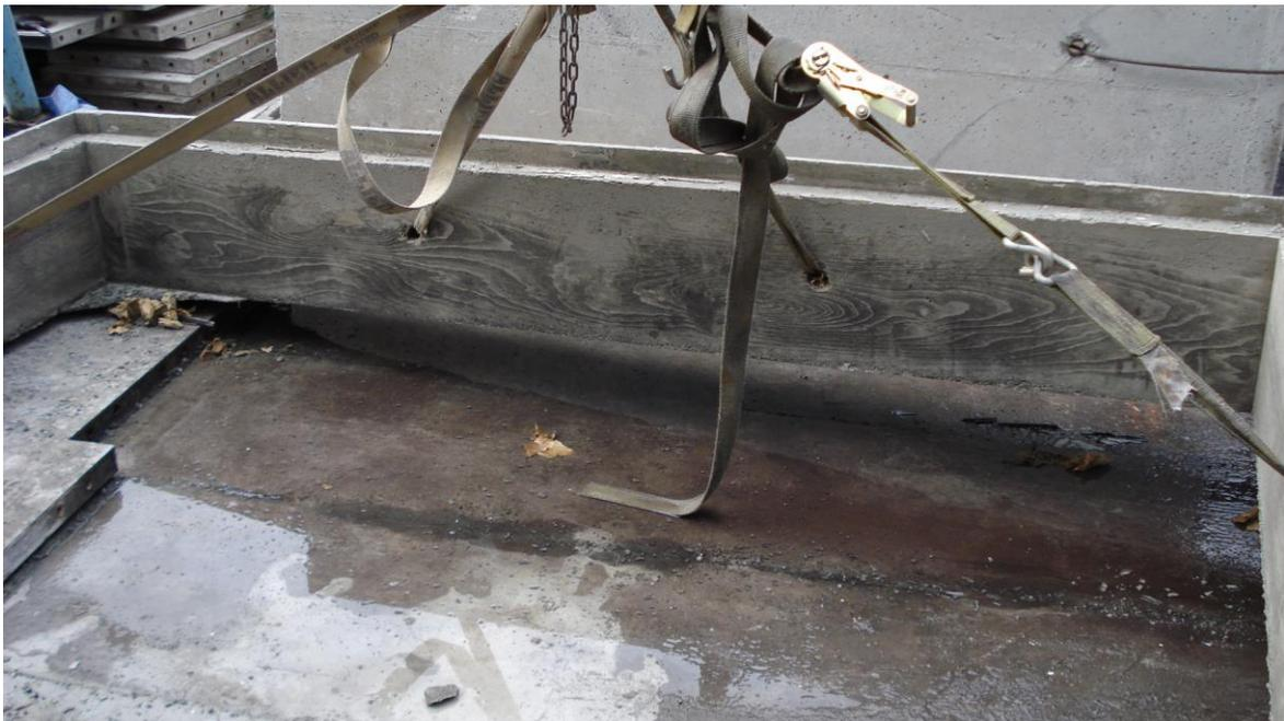
*Figura 35, Elemento de Caja de infiltración, (Pieza#1 zapata de cimentación de caja de infiltración prefabricada)
