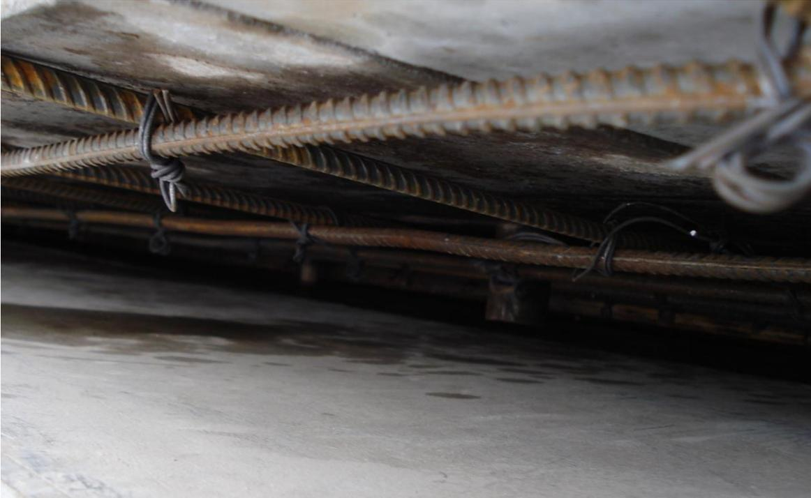
*Figura 15, acero de refuerzo en pieza2 anillo de caja de infiltración prefabricada
