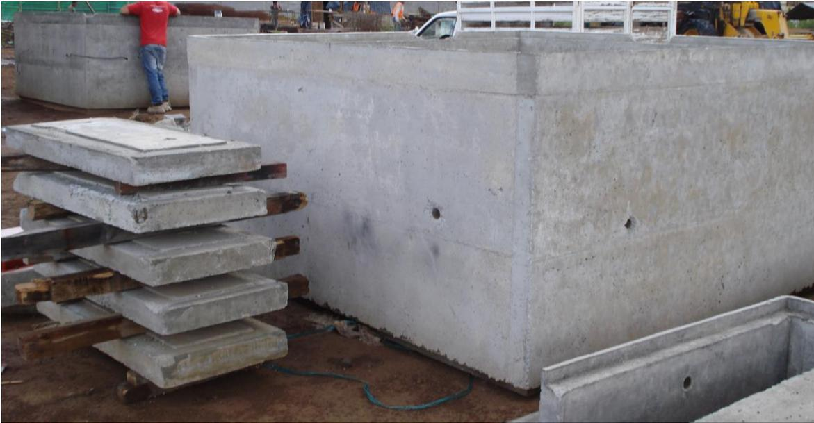
*Figura 23, entrega de piezas prefabricadas en sitio de obra para su instalación.
