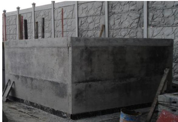
Figura 3, Anillo cuadrado para caja de infiltración prefabricado Fuente: propia Referencia: plano 2-A
