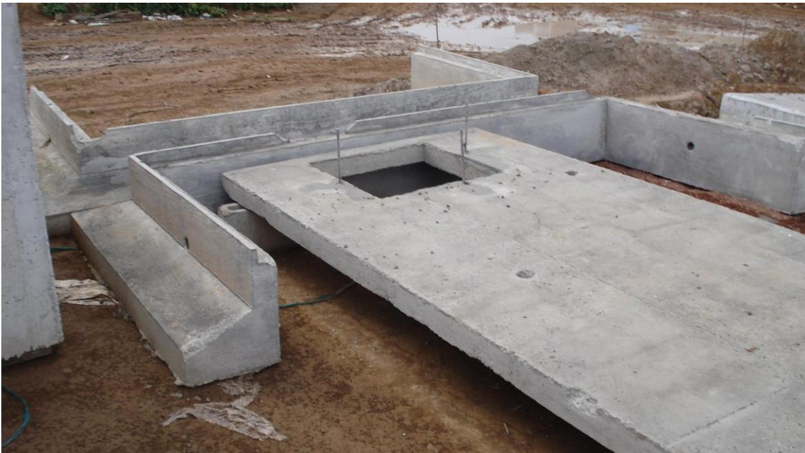
*Figura 24, entrega de piezas prefabricadas en sitio de obra para su instalación.
