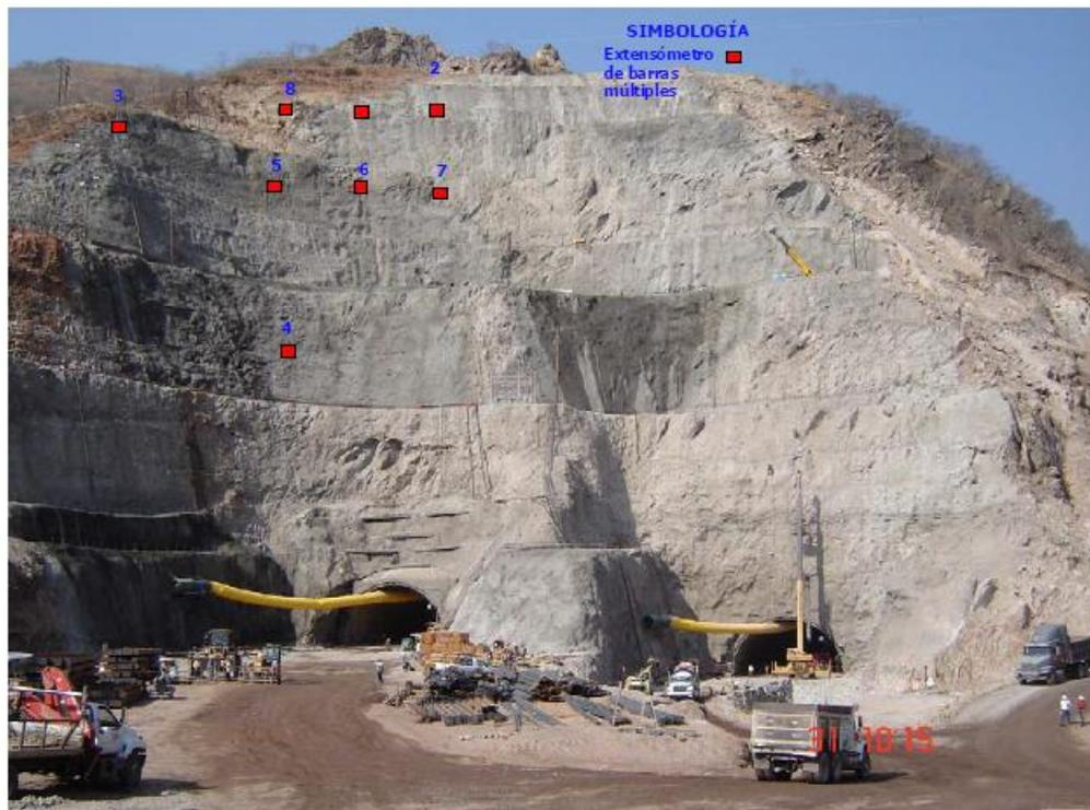
Figura 2. 13 Localización de los extensómetros de barra, primera etapa.
