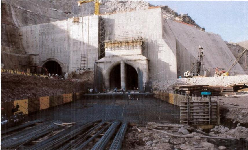
El monolito de concreto simple construido representa 76 800 m<sup>3</sup> de volumen. A esta estructura se adicionó una lateral de 33 000 m<sup>3</sup>, para formar el apoyo a la ataguía de aguas arriba. Así, el volumen de concreto total de esta obra extraordinaria ascendió a 109 800 m<sup>3</sup>, que corresponden aproximadamente a 260 mil toneladas de peso.
