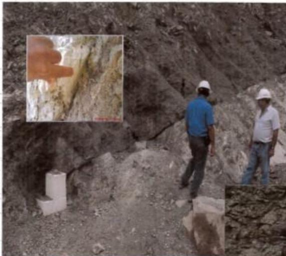
El 14 de mayo de 2008, se confirmaron los desplazamientos de esta gran masa de roca inestable, claramente manifestada en la elevación 448,0 m del talud del camino 6MI (falla Colapso), mostraba su plano de discontinuidad relleno con arcilla plástica, que contenía estrías producidas por movimientos lentos del tipo creep.
