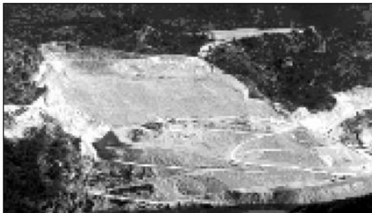
*Figura 2. 33 Ladera izquierda del Júcar, aguas arriba de la Presa de Cortes, inmediatamente después de terminarse los trabajos de estabilización del deslizamiento.*
