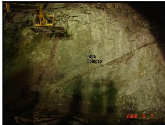
Figura 2. 3 Falla colapso en el túnel de desvío 1.
