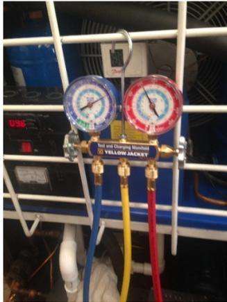
*Figura 6 Medidores de presión conectados al enfriador.*
