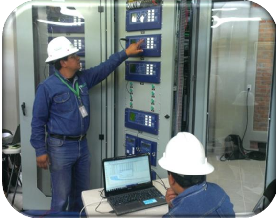
Fig. 11.- Pruebas a esquemas de protección
