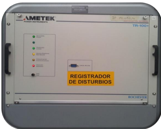
Fig. 12.- Registrador de disturbios
