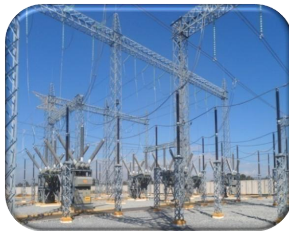
Fig. 1.- Arreglo doble barra doble interruptor
