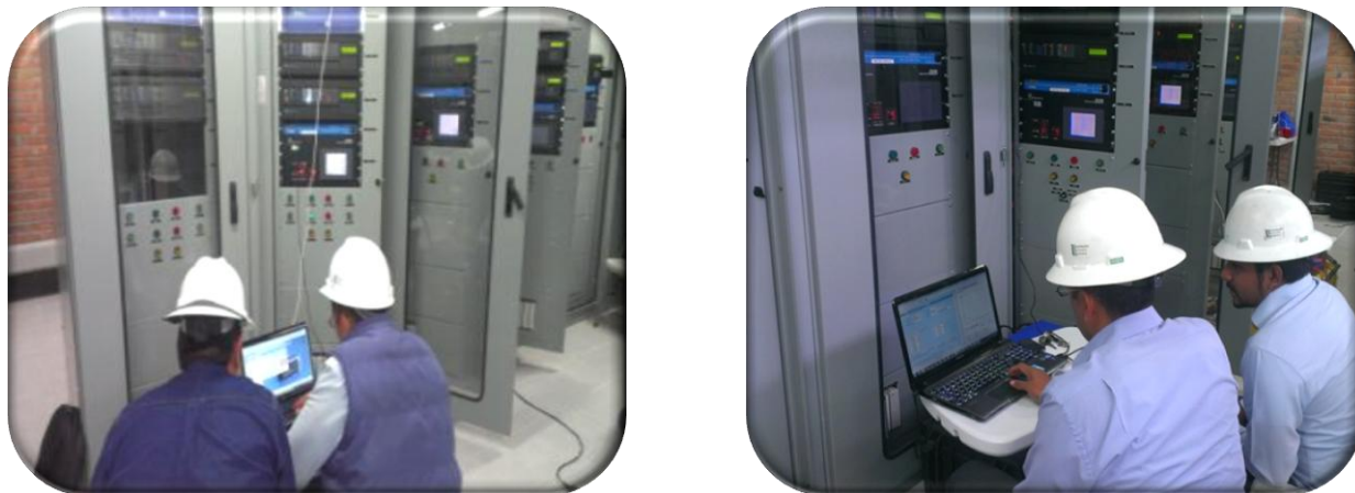
Fig. 6.- Pruebas operativas a relevadores
