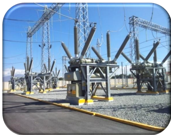
Fig. 1.- Arreglo doble barra doble interruptor
