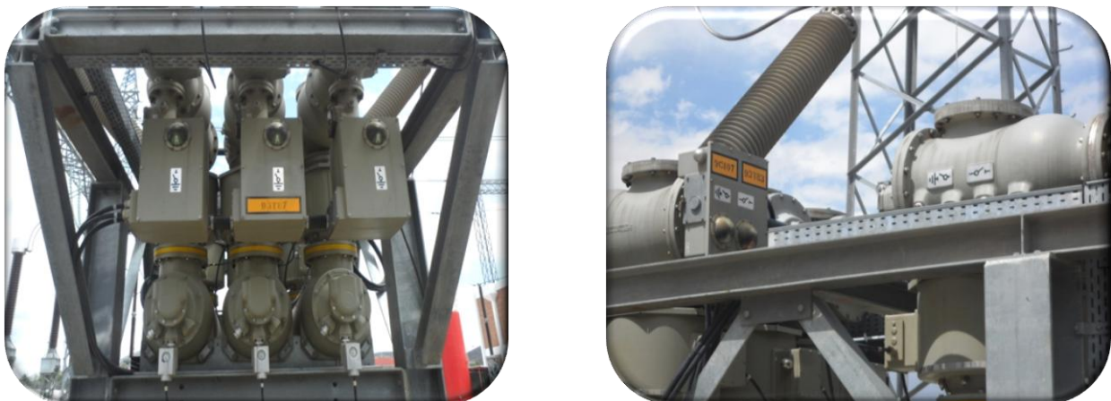
Fig. 9.- Cuchillas en los módulos híbridos
