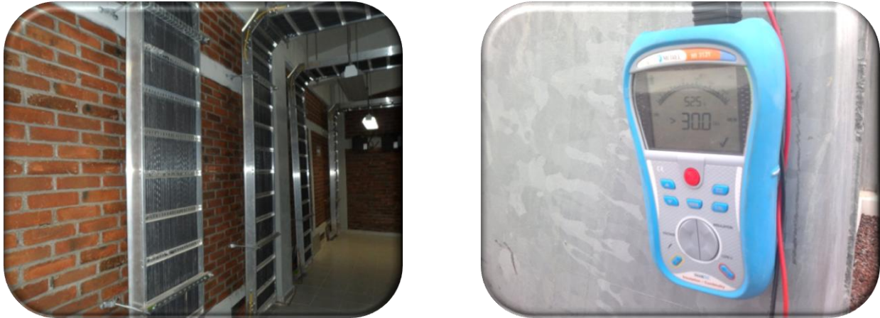
Fig. 14.- Tendido y pruebas al cable de control
