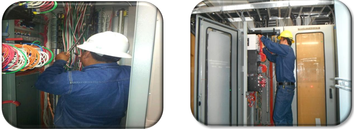
Fig. 5.- Revisión de tableros de protección
