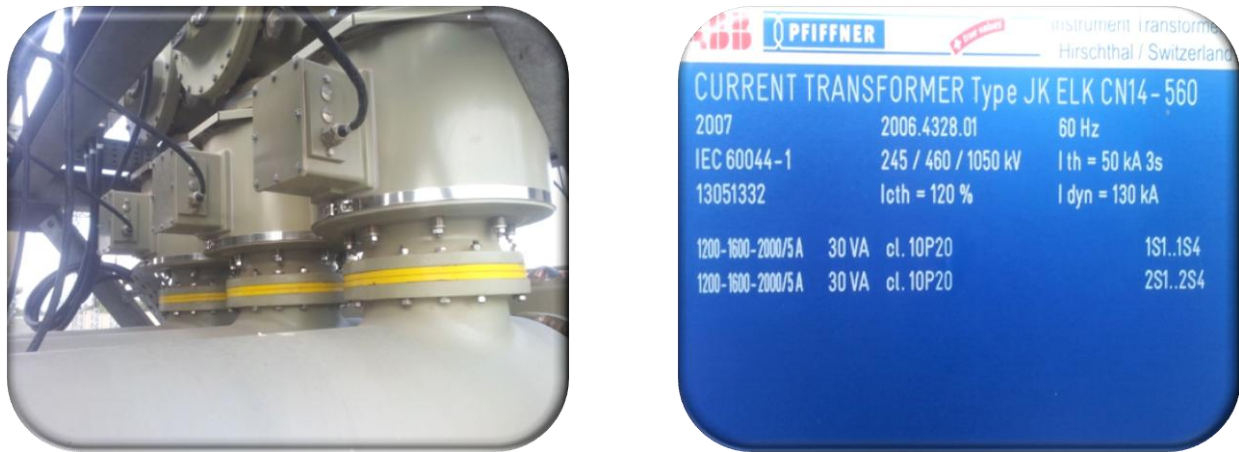
Fig. 10.- Transformadores de corriente
