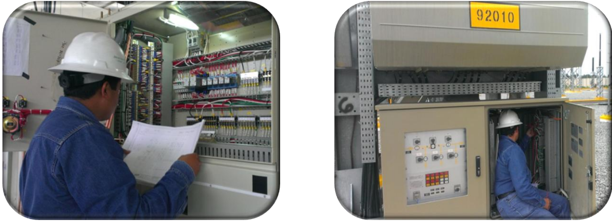
Fig. 8.- Interruptor de 23 Kv y 230 Kv
