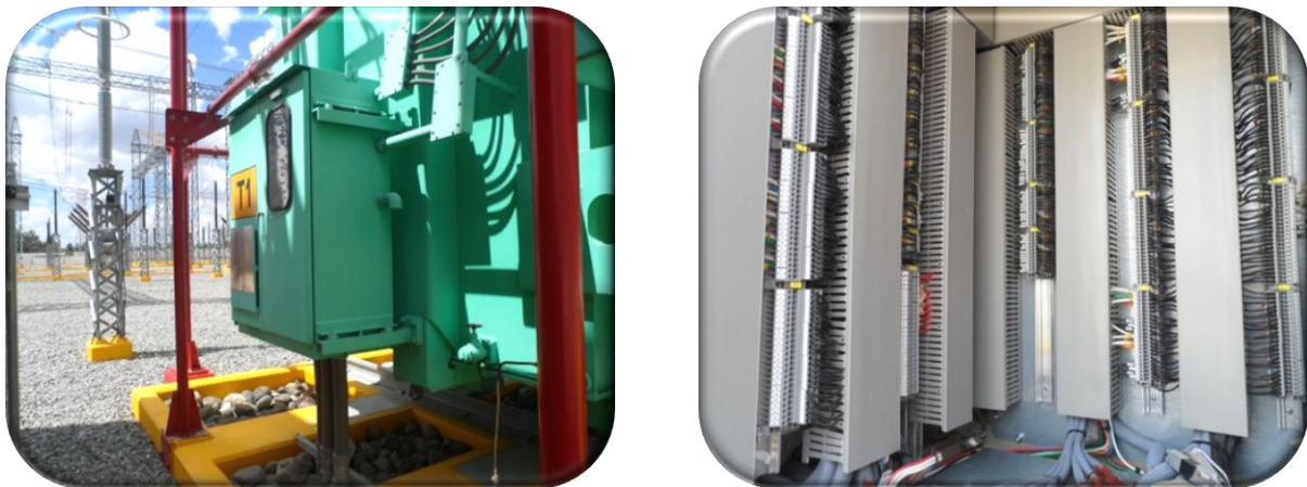
Fig. 15.- Gabinetes centralizadores
