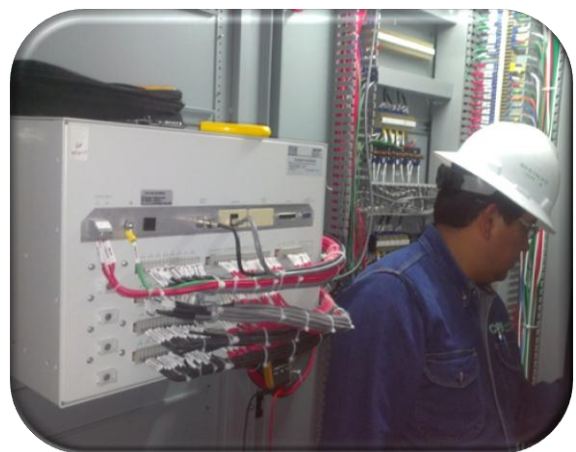
Fig. 12.- Registrador de disturbios
