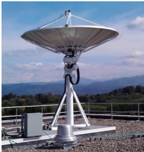
*Figura 3.1 Antena estación terrena*
