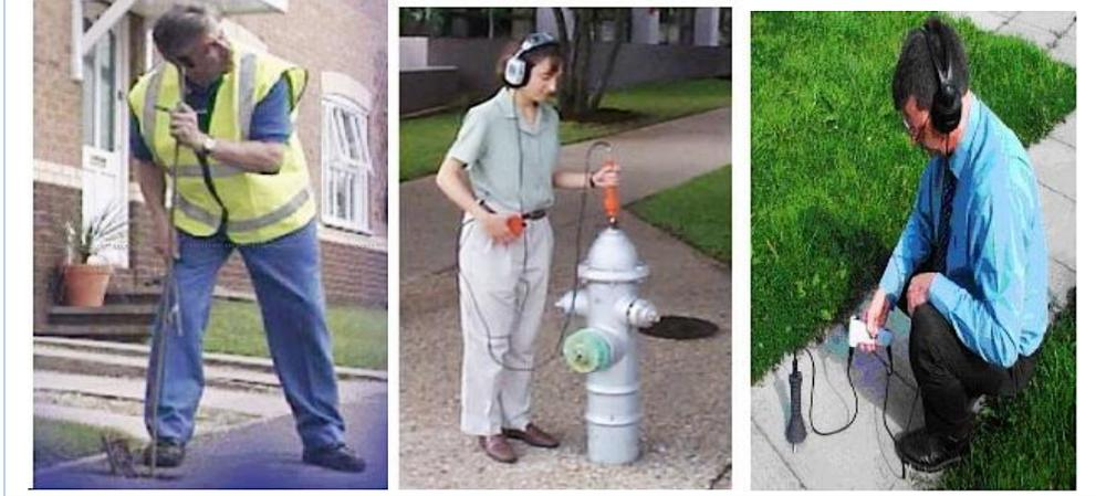
Figura 2.11. Localización de fugas por métodos acústicos directos. Fuente: Vargas (2009)
