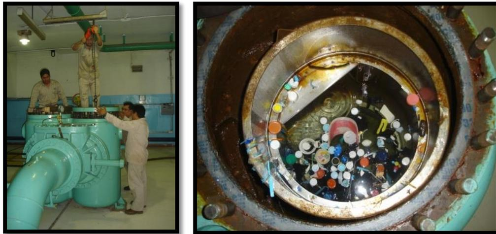
Figura 7-18. Obstrucción por tapa-rosclas hacia el filtro del sistema de enfriamiento de las turbinas de la CH Chicoasén.
