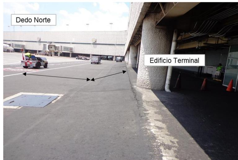
Figura 2. 6 Asentamiento diferencial entre el Edificio Terminal y el Dedo Norte del Aeropuerto Internacional de la Ciudad de México, Terminal 2
