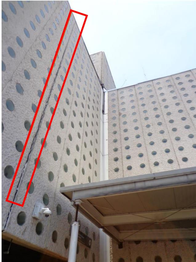
Figura 6. 11. Grieta a lo largo de los paneles de concreto del Dedo Sur
