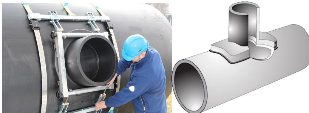
Figura 2.13. Soldadura de silleta.
