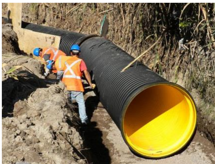
Figura 2.6. Tubería de polietileno reticulado con pared interna lisa.
