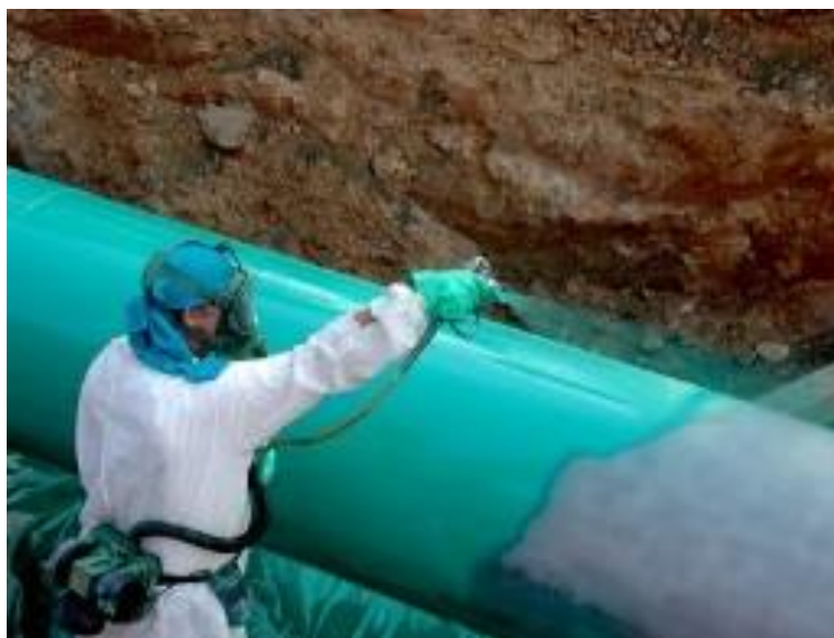
Figura 1.10. Colocación de revestimiento externo a una tubería de acero.
