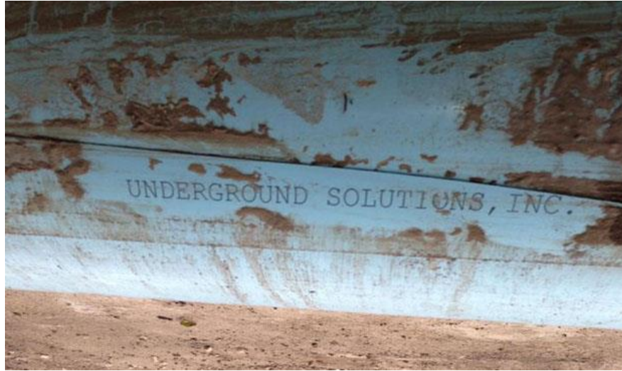
Figura 4.17. Tubería de PVC de 12" con RD18 – Jacksonville, FL– Falla tipo PRF de 6 metros de longitud (Palermo , 2010)
