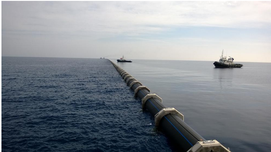
Figura 2.5. Tubería de HDPE como emisor submarino.
