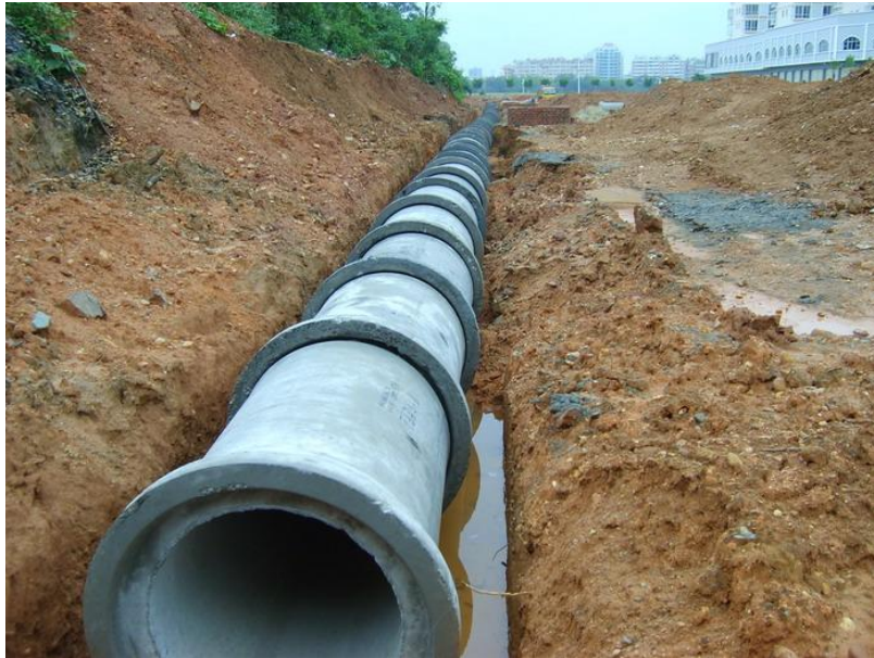
Figura 1.4. Tubería de concreto con junta tipo espiga-campana.
