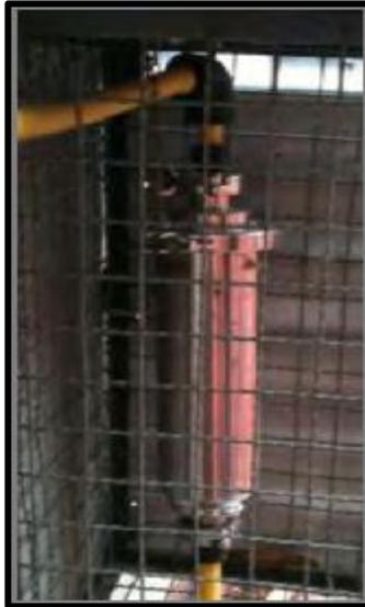
Figura 3.15 Desulfurador de biogás (Grimaldo, 2013)
