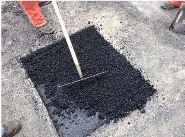
*Figura 2.3. Colocación de mezcla asfáltica fría*
