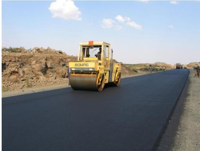
*Figura 2.7. Uso del concreto asfáltico en carreteras*
