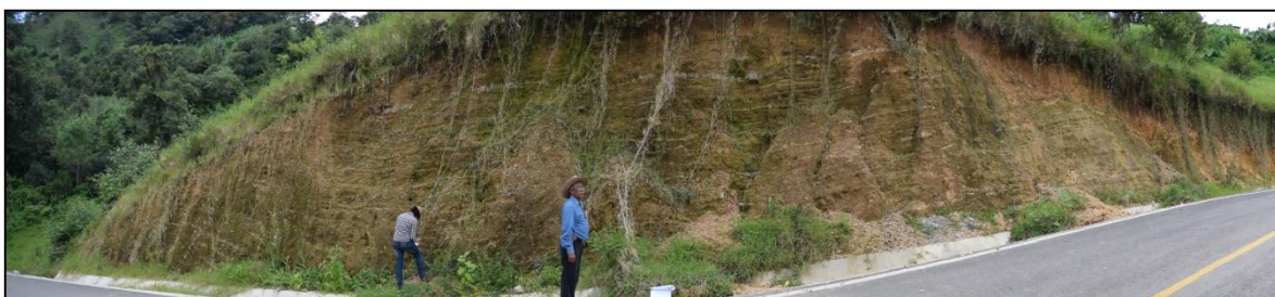
Fotografía 5.15. Panorámica donde se observa a la Formación Agua Nueva que presenta una coloración café, por el alto grado de intemperismo y estratos de poco espesor (San Agustín, Puebla).
