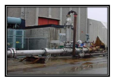
Figura 4-12 Desgasificador para la plataforma Statfjord - B, Statoil (Modificado de Schook et al., 2005).
