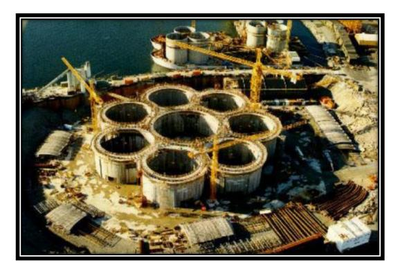
Figura 4-26 Construcción de una unidad de separación y almacenamiento submarino (Modificado de Eie, 2015).
