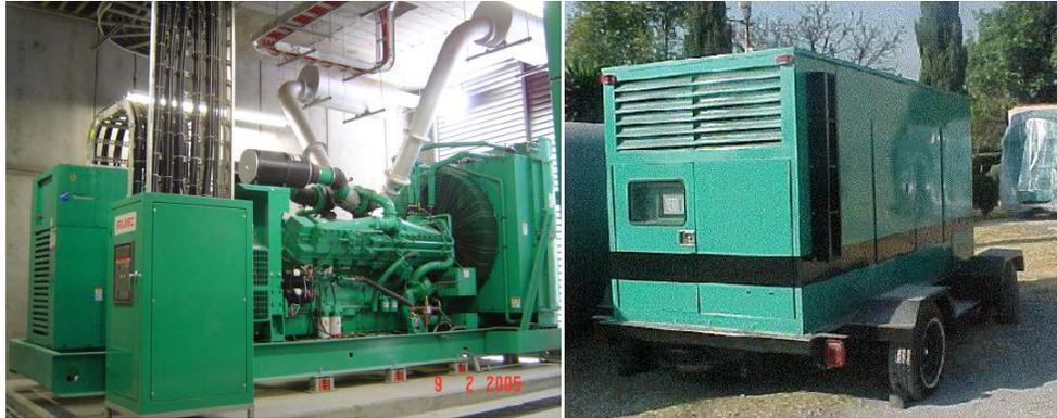
Fig.11. a) Planta de Emergencia, b) Planta de Emergencia con caseta acústica y remolque integrado. Fuente: [www.ciaeh.org.mx](http://www.ciaeh.org.mx)
