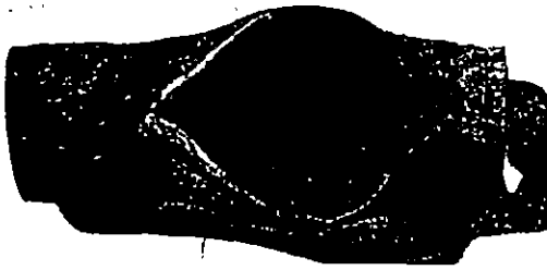
Figura 39.4 Rotura típica de un tubo causada por sobrecalentamiento.
