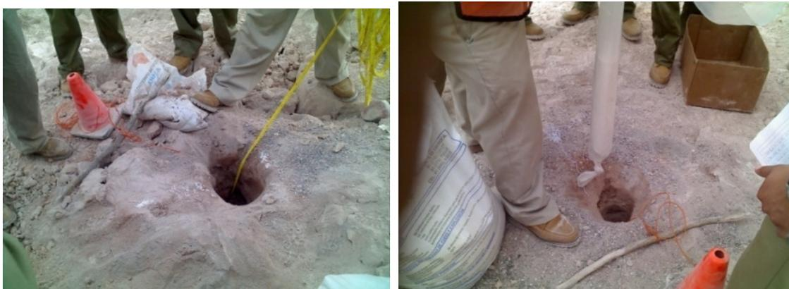
**Ilustración 21. Cargado de barrenos**
