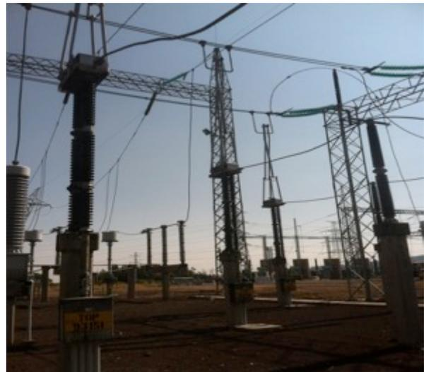
Fig. 6.6.b Cuchilla tipo pantografo
