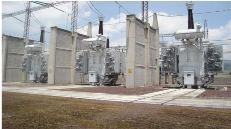
Figura 2.1.2. Banco de Autotransformadores 400/230 kV.
