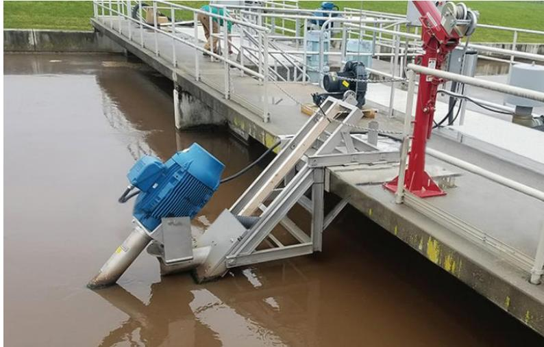
Figura 4.11.-Montaje del mezclador
