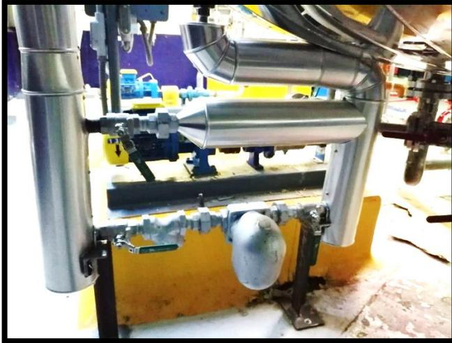
*Ilustración 58 Instalación de tubería de condensado*
