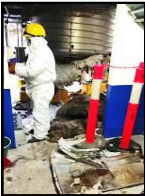
*Ilustración 45 Desmantelamiento con equipo de protección personal.*
