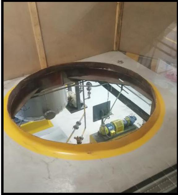
*Ilustración 46* Agujero al dismantelar tanque.
