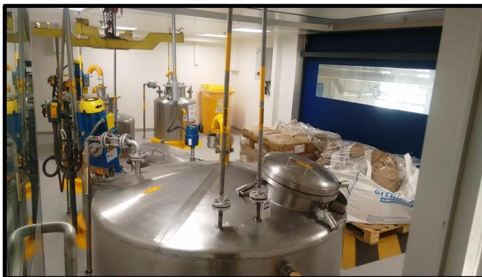
*Ilustración 16 Cuarto de preparación de ácido cítrico.*
