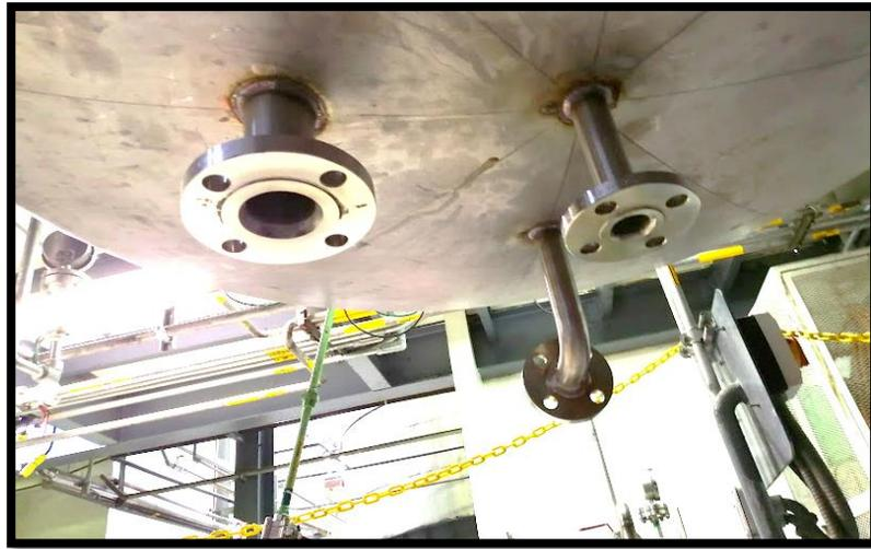
*Ilustración 51 Boquillas soldadas a nuevo tanque*
