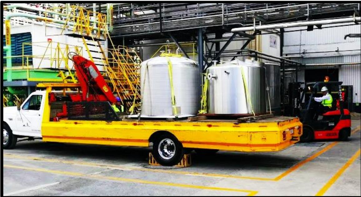
*Ilustración 50 Llegada de nuevo tanque a planta. 4,500 [lts]*
