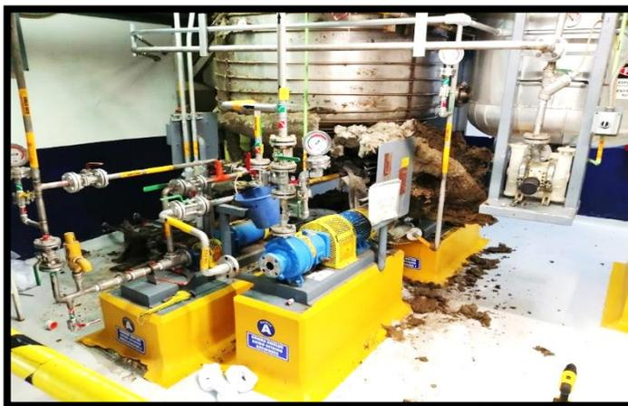
*Ilustración 44 Desmantelamiento de enchaquetado de tanque.*
